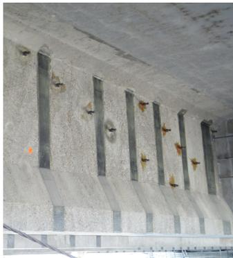
Figure 11 : injecteurs en place le long du tracé des câbles relevés
