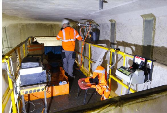
Figure 13 : poste de travail sur nacelle de l'atelier d'imprégnation d'inhibiteur de corrosion dans les gaines de précontrainte
