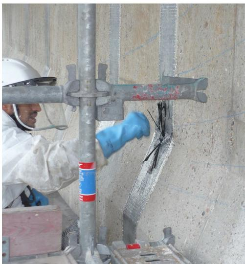
Figure 5 : mise en œuvre d'une mèche d'ancrage anti-poussée au vide sur une bande de TFC de renfort à l'effort tranchant
