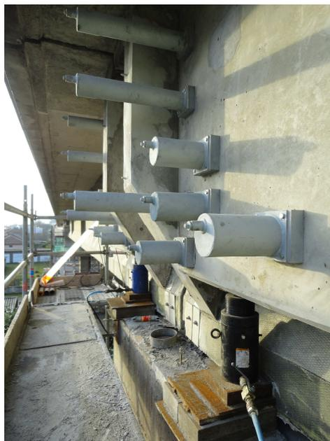
Figure 8 : about de poutre de rive : massif béton d'ancrage des monotorons et barres de précontrainte de serrage pour reprise des efforts de vérinage
