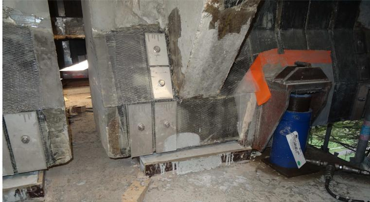
Figure 7 : abouts de poutres : ancrage du TFC par plaque inox
