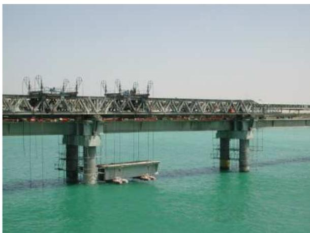
*poutre de lancement équipée de 12 vérins à câble*
