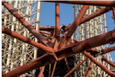
*Figure 9c - détail des nœuds d'assemblage des tubes métalliques*
