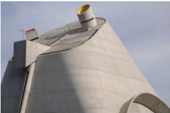
Façade Ouest de l'Eglise vue de l'extérieur
