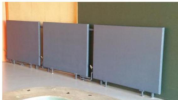
Radiateurs en béton
