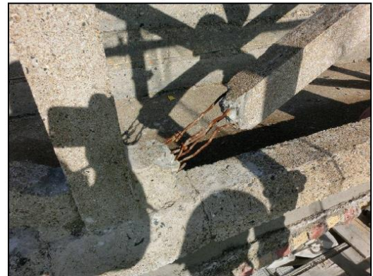
○ Réparation des garde-corps sur zones ponctuelles
