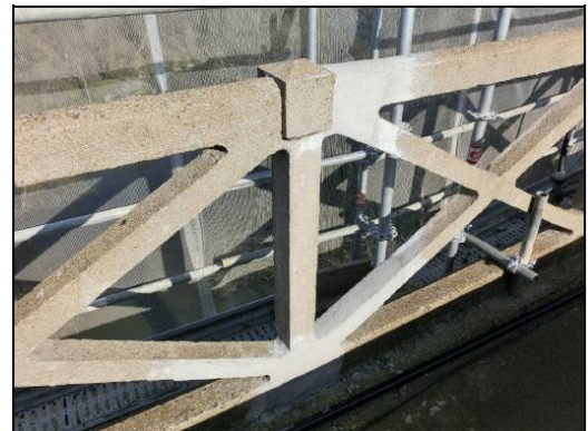
○ Réparation des garde-corps sur zones ponctuelles
