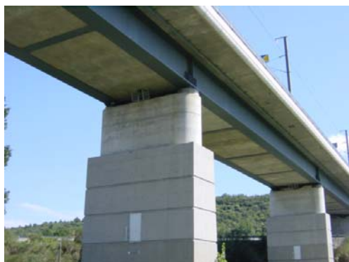
Fig. 1 : Lower torsional non composite concrete slab – Bonpas viaduct TGV Méditerranée
