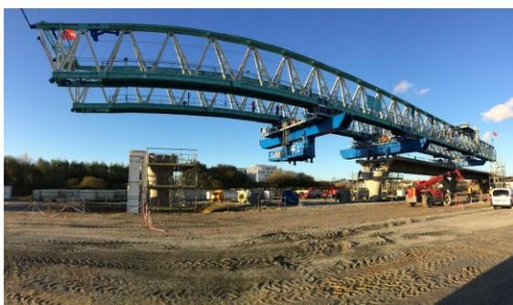
Avancement de la poutre de lancement par déplacements successifs de ses pieds et de la structure
