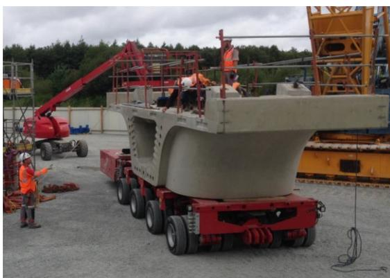
Approvisionnement des voussoirs pré-équipés avec un fardier circulant sur le tablier déjà construit
