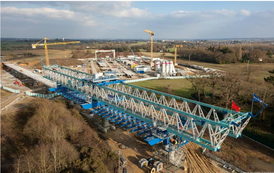
Poutre de pose capable de suspendre la totalité de 2 travées
