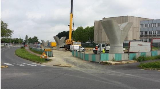
Fondation des appuis sur pieux ou sur fondations superficielles avec substitution de terrain (32/70 d'appuis sur pieux de 6 à 20 m environ)
