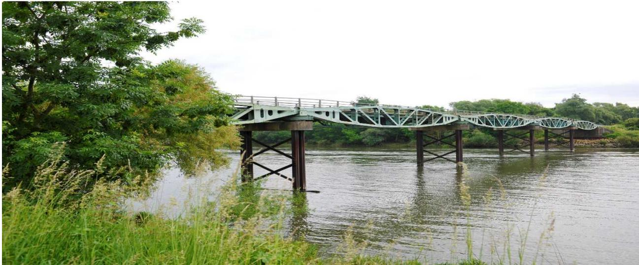
Ces poutres proviennent d'une récupération d'ouvrages qui ont été utilisés lors de la réalisation de ports artificiels lors du débarquement en Normandie; Pour relier ces jetées à la terre ferme, il est nécessaire de fabriquer les « whales » (littéralement baleine) qui sont en fait des passerelles flottantes métalliques
