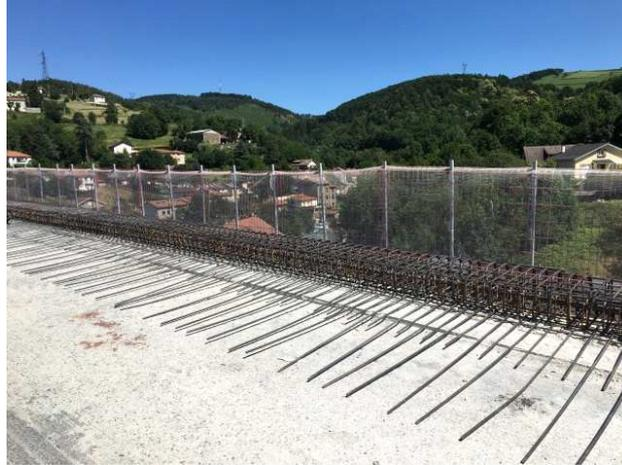
*Ferrailage des longrines en encorbellement sur lesquelles seront scellés les dispositifs de retenue*
