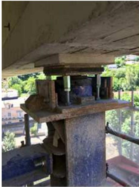
*Détails sur dispositif d'appui provisoire*
