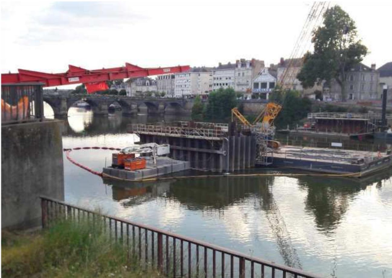
L'ouvrage repose sur deux piles en rivière de forme cylindrique et revêtues d'un parement pierre. Ces piles sont surmontées de béquilles métalliques, les « tétrapodes », venant soutenir les deux poutres-caissons du tablier.
