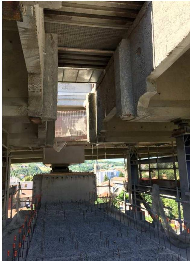
*Chevêtre et tenon démolis (au premier plan, tablier Sud) et nouveau chevêtre, entretoise et appareil d'appui définitif (arrière-plan, tablier Nord)*
