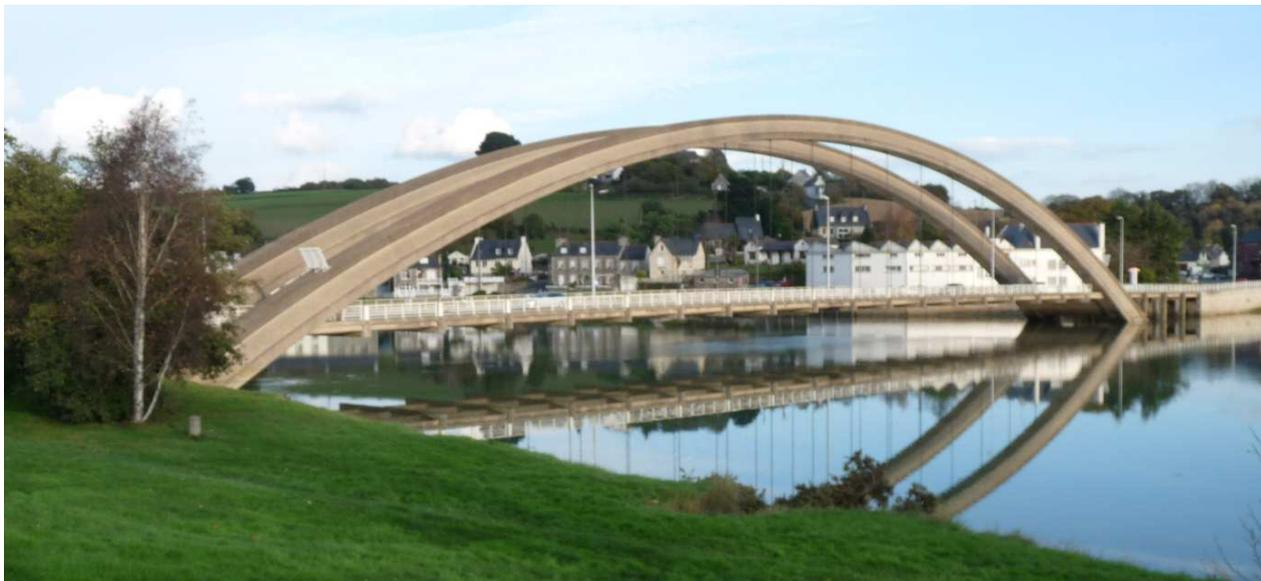
Construit entre 1952 et 1954 par l'entreprise COIGNET, l'ouvrage est un pont en arcs en béton armé constitué d'un tablier suspendu. Avec une portée de 153 mètres il occupait, à l'époque le 2ème rang mondial. Sa flèche est de 26 mètres et sa longueur totale de 179,65 m.
