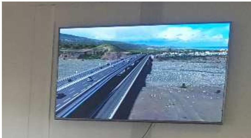
Cet ouvrage viendra sécuriser la traversée de la Rivière des galets en remplacement des 2 ouvrages existants. Il accueillera tous les modes de transports avec 3 voies dans chaque sens, plus une voie côté mer pour les piétons et 2 roues.
