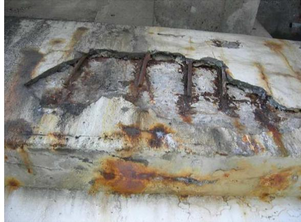
*Appareil d'appui dégradé*
