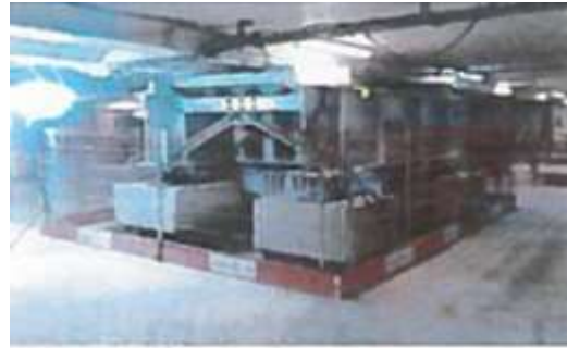
Reprise des poteaux
