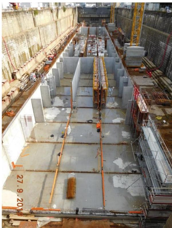
Élévation des voiles du caisson
