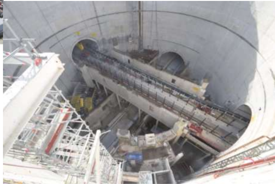
Vue du puits (février 2020 – source : SGP)
