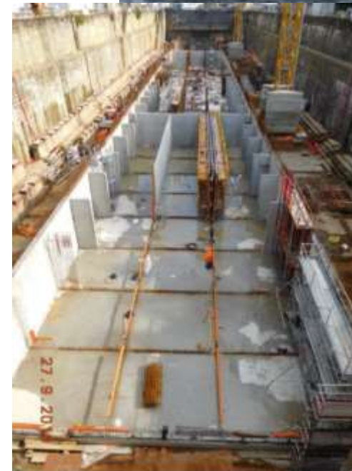
Elévation des voiles du caisson
