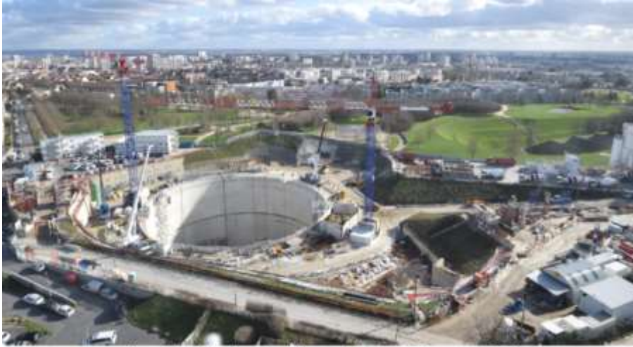
Vue générale du chantier de la gare (février 2020 – source : SGP)
