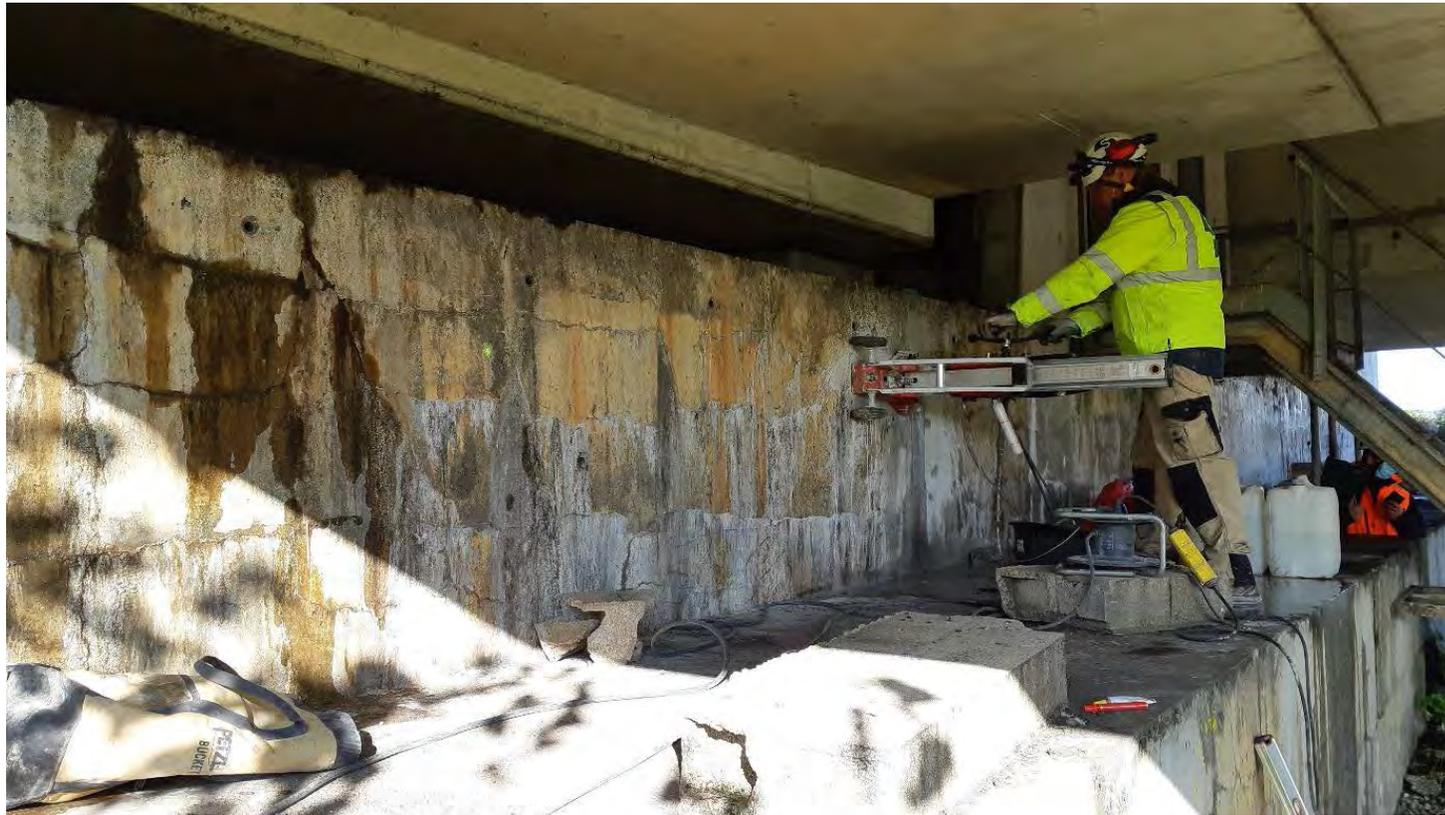
*Prélèvement de carottes de béton*
