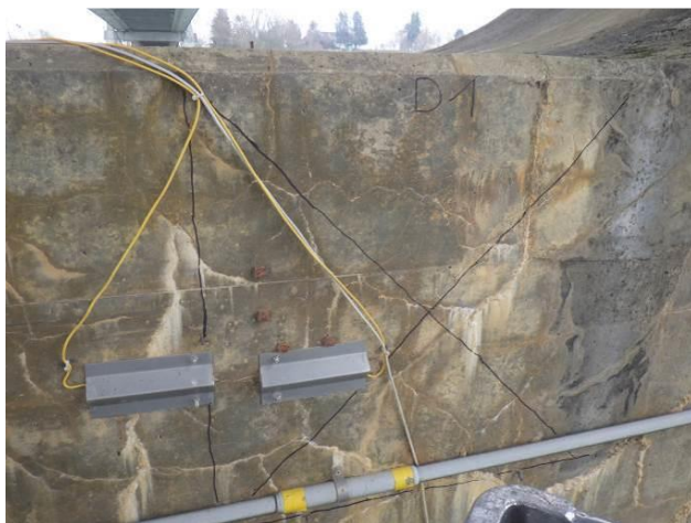
Figure 1 : Relevé des fissures au droit du trièdre D1
