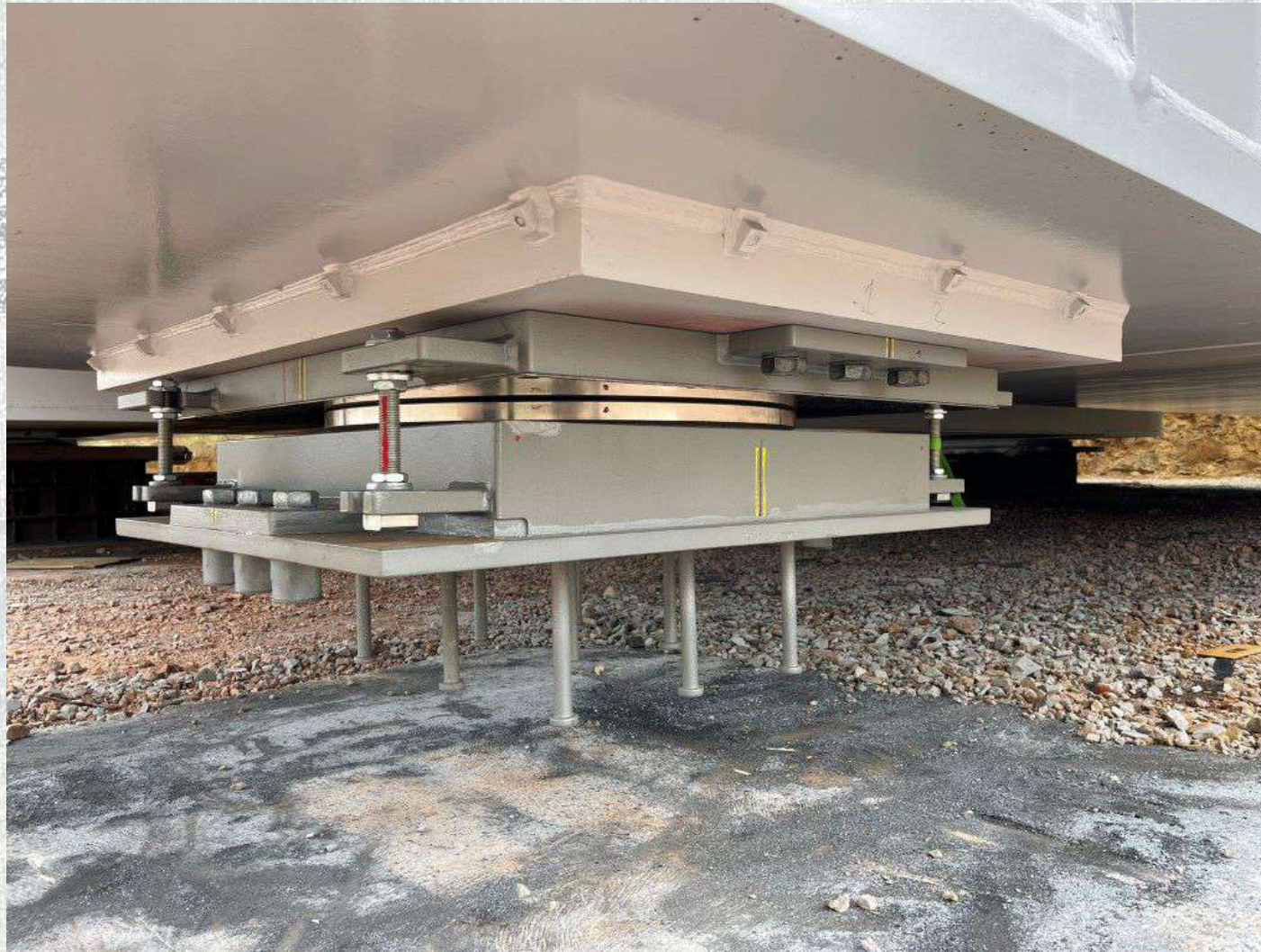
Montage à blanc sur l'ouvrage
