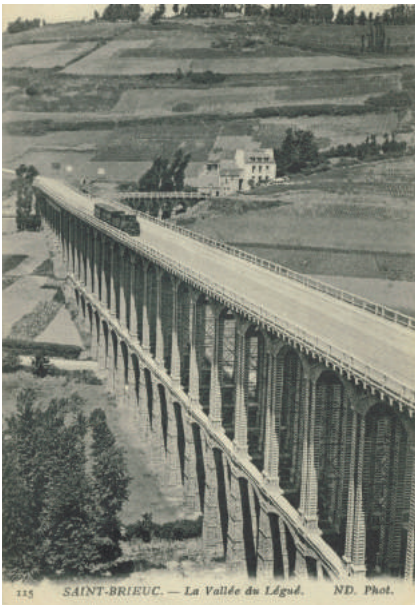
Figure 5 : Viaduc de Souzain entre Saint-Brieuc et Plérin.
