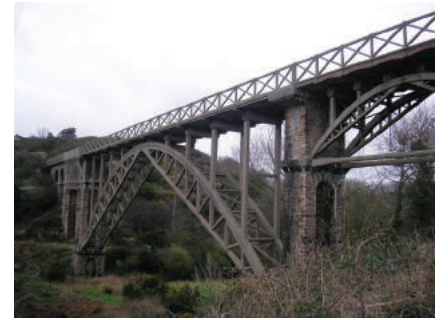
Figure 13 : Viaduc de Caroual à Erquy et son arc central parabolique de 45 mètres d'ouverture.
