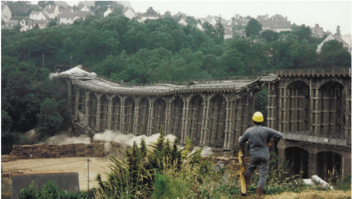
Figure 14, ci-dessus : Dynamitage du viaduc de Souzain en juin 1995.
