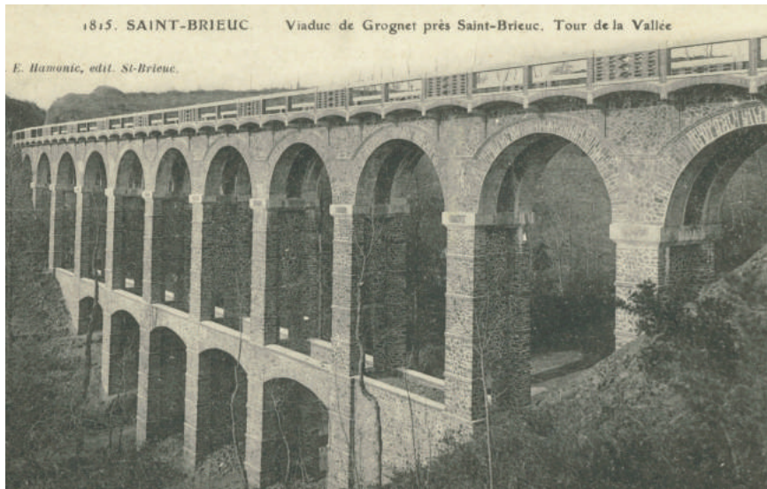
Figure 9 : Viaduc de Grognet, ouvrage caractéristique du 1 er réseau des chemins de fer des Côtes-du-Nord
