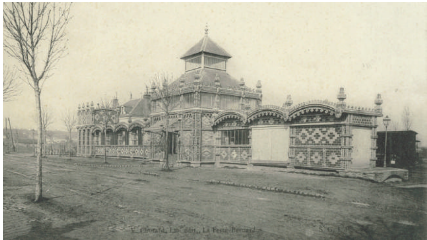
Figure 2 : Gare de La Ferté-Bernard dans la Sarthe, construite en 1898.
