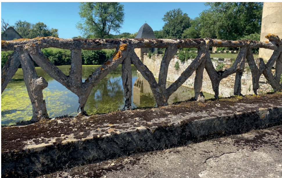
Les « rocailles » assurant la fonction garde-corps du tablier © P. Guiraud
