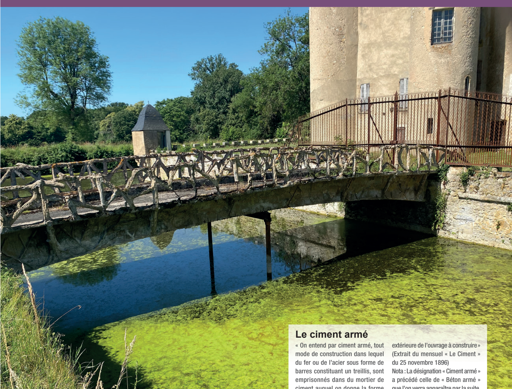
Le pont de Chazelet franchit les douves du château © P. Guiraud
