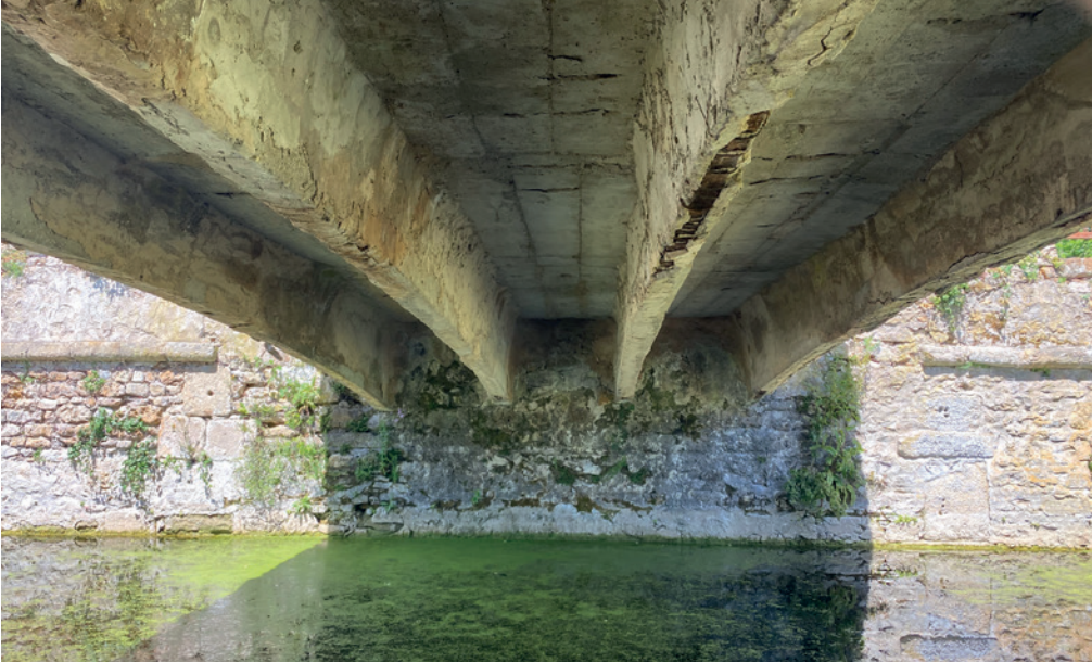
Vue du dessous du tablier © P. Guiraud
