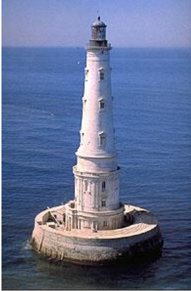
(© Association pour la sauvegarde de Cordouan)
