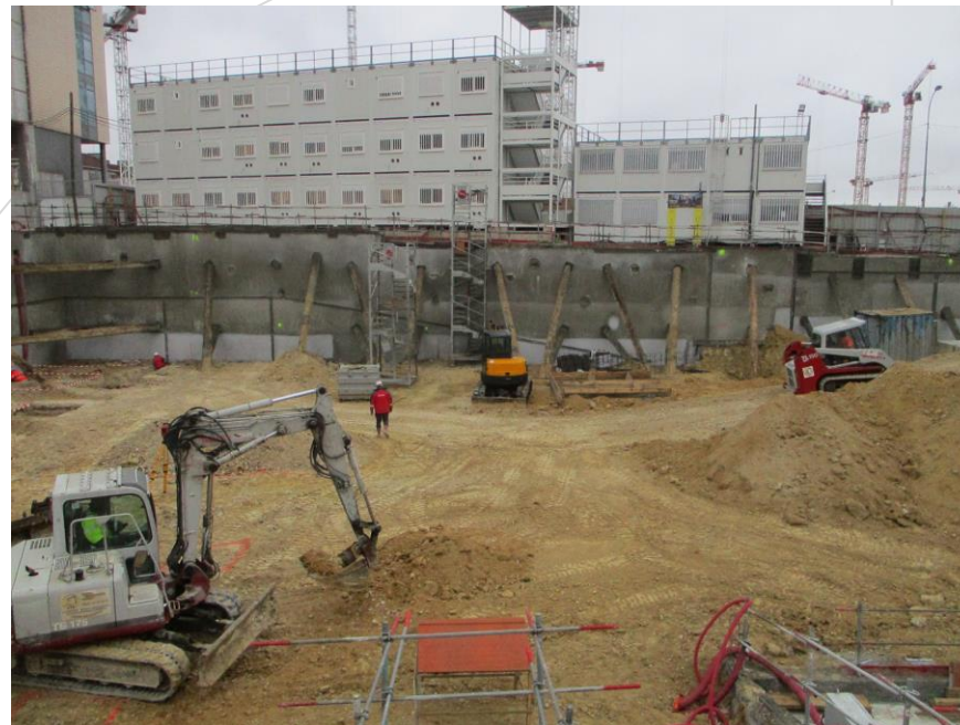
Voiles par passe avec butonnage provisoire
