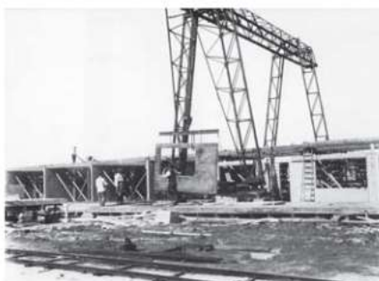
Immeuble en construction au Betondorp utilisant le procédé de préfabrication Bron.
