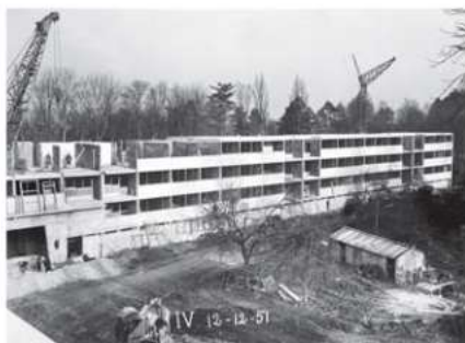
Chantier du SHAPE Village.
