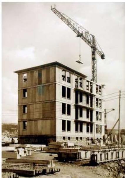
Montage d'un immeuble de la cité des Champs-Barets au Havre avec le procédé ETM.
