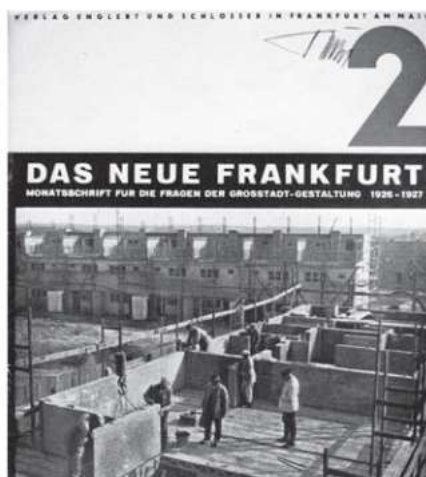
Couverture du deuxième numéro de la revue Das Neue Frankfurt montrant le montage des panneaux préfabriqués à la cité de Praunheim.
