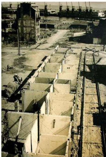
Immeubles en construction au sein de l'ilot N17 du Havre. Panneaux verticaux provisoirement maintenus en attente des dalles de plancher.
