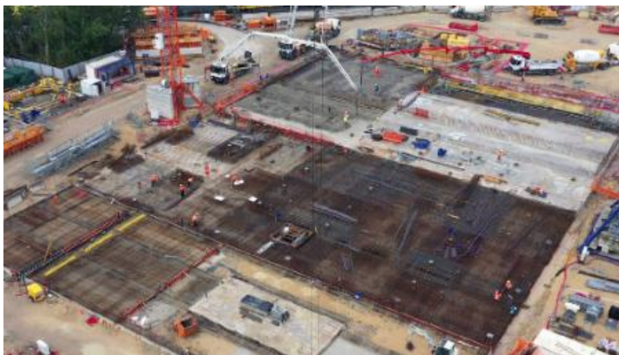
Radiers de 80/92 cm d'épaisseur avec pentes intégrées.
