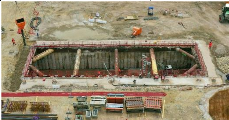
Fosses 32x6x8 étanchéité et soutènements par pieux sécants
