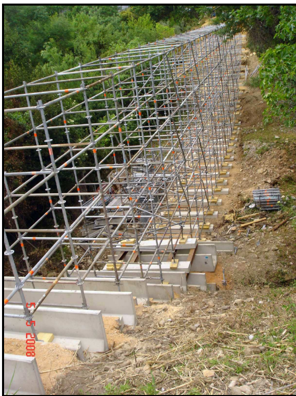
Fig.6 Vue du cintre en cours de montage
