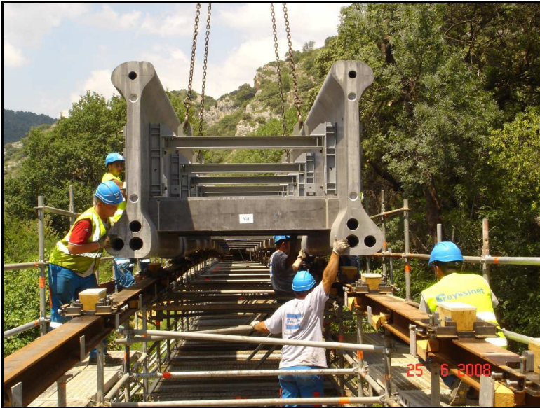
Fig. 7 Vue de la pose d'un voussoir
