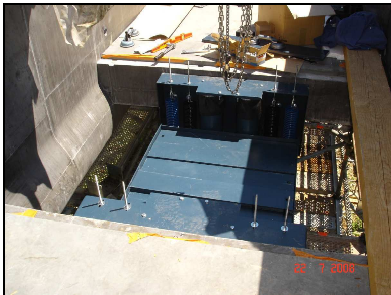
Fig. 9 Mise en œuvre des amortisseurs dynamiques
