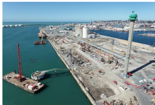
Le Havre – Ré- aménagement du quai Joannès Couvert : 22 juin
