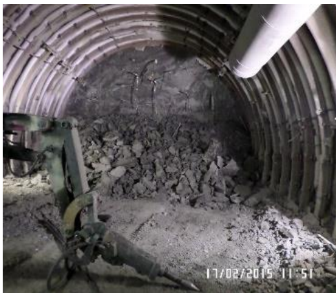
Intégration de cintres coulissants
