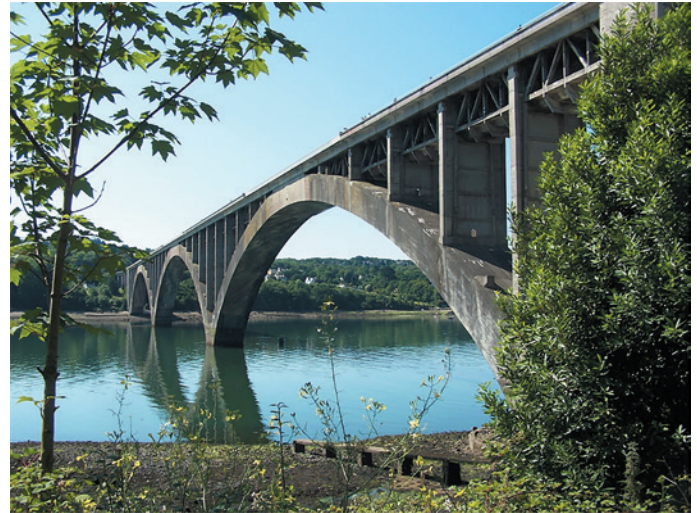
Pont Albert Louppe à Brest © Association Freyssinet
