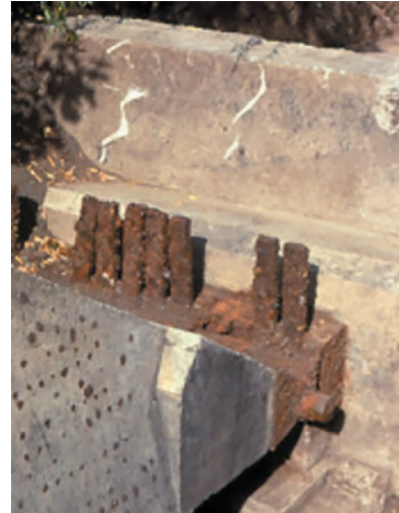
Figure 6 - Photo de l'articulation côté Est © P.Jartoux
