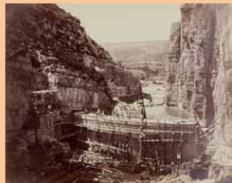
Le barrage du Verdon en construction (1869) Barrage de prise déversant en tête du canal du Verdon. ©Bibliothèque Méjanès, Aix-en-Provence
