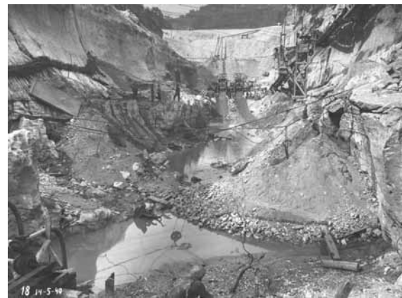
Génissiat, excavation des fondations à l'abri du batardeau (1940) ©CNR.
