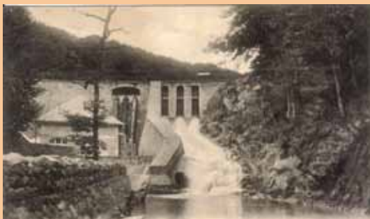
La Bourboule (1896), une des premières usines hydroélectriques
