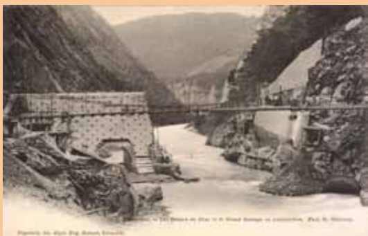
Avignonnet (1903) en construction
