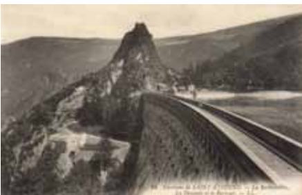
barrage du Furens (1866)
