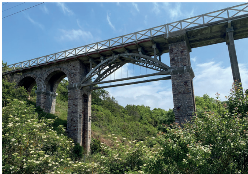
Les 2 arches latérales du viaduc de Caroual à Erquy © P. Guiraud
