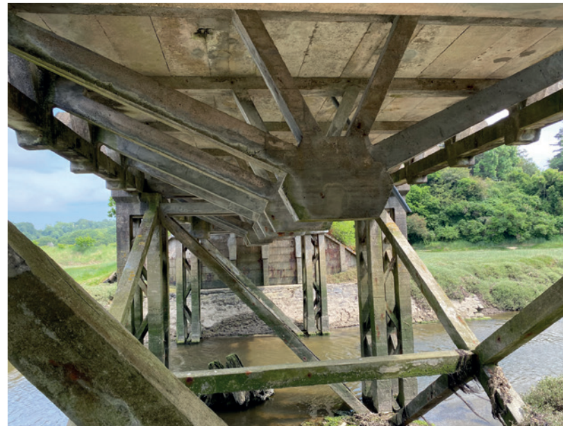
Le pont du Marais à Plurien (second réseau / ligne Yffiniac-Matignon) / Tous les éléments ont été préfabriqués à proximité du chantier puis assemblés tel un mécano grâce à des armatures en attente © P. Guiraud
