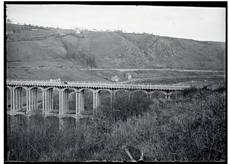
Viaduc de Souzain à Plérin, ferroviaire et routier, construit en 1904 (premier réseau, ligne Saint-Brieuc-Plouha, 274 m de longueur, 32 m de hauteur, piles en maçonnerie en double T), inscrit au titre des Monuments historiques en 1993 puis détruit par dynamitage (Négatif sur verre, studio R. Binet photographe, collection Musée de Bretagne)
