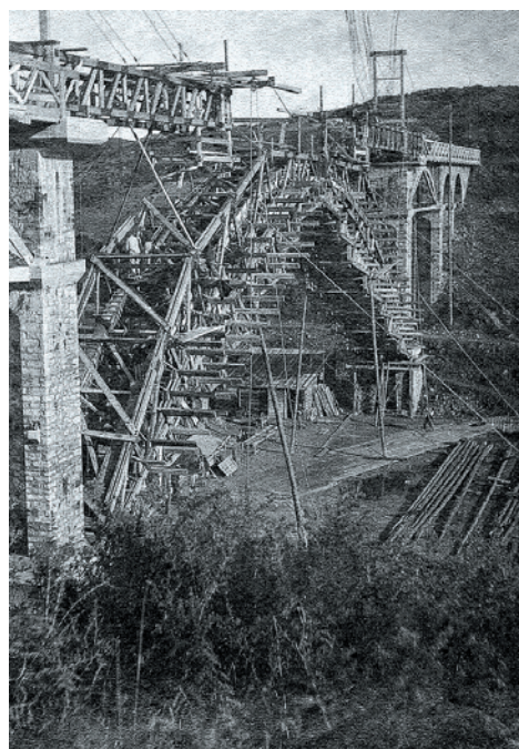
Durant la construction du viaduc de Caroual, la mise en place du coffrage de l'arche centrale (photo par Ernest Besnier Février 1916)
