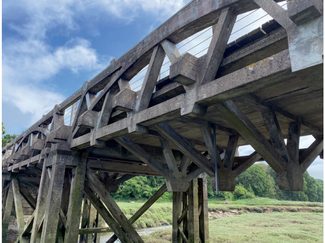
Le pont du Marais à Plurien (second réseau / ligne Yffiniac-Matignon) / Tous les éléments ont été préfabriqués à proximité du chantier puis assemblés tel un mécano grâce à des armatures en attente © P. Guiraud
