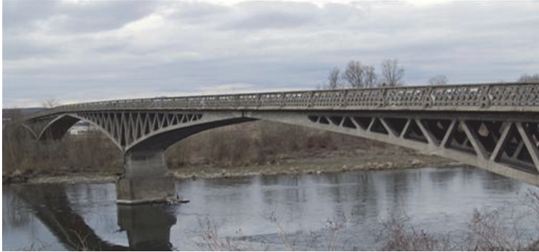
Figure 1.1. Le pont Boutiron sur l'Allier (IFSTTAR).
