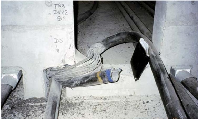
Figure 2.49. Viaduc de Val-Durance, fouettement d'un câble rompu (D. Poineau).
