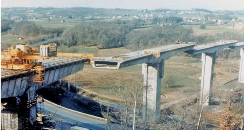
Figure 2.40. Construction des fléaux du viaduc de l'Arrêt-Darré avant leur basculement (SETRA).
