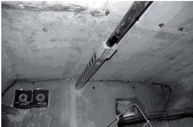
**Figure 2.52.** Viaduc de Saint-Cloud : amortisseur en place avant la coupe du câble (LCPC).
