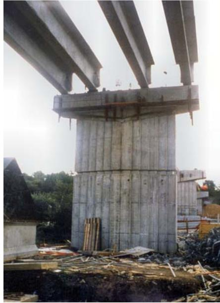
**Figure 2.57.** Pont de Bernay, poutres sur cales et non contreventées (D. Poineau).
