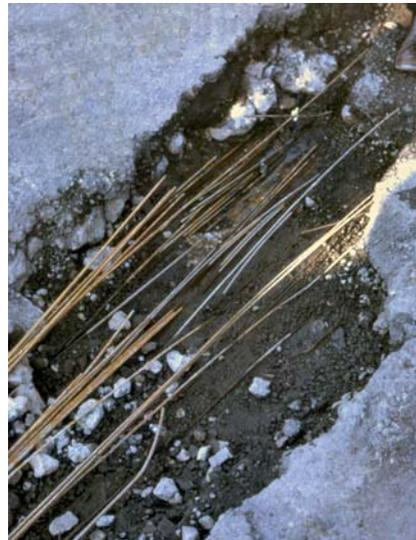
**Figure 2.12.** État de certains des câbles du pont d'Esquerchin (D. Poineau).
