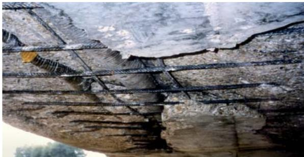
**Figure 2.58.** Pont de Montereau, poussée au vide provoquant le feuilletage du hourdis (D. Poineau).
