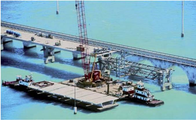
**Figure 2.31.** Le pont de Long Key (Floride) en cours de construction (Association Eugène Freyssinet).
