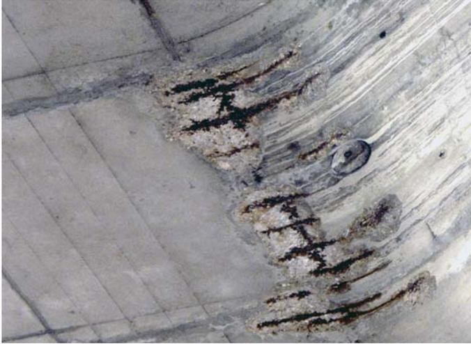
**Figure 2.64.** Corrosion des armatures passives sur un pont en BP (D. Poineau).
