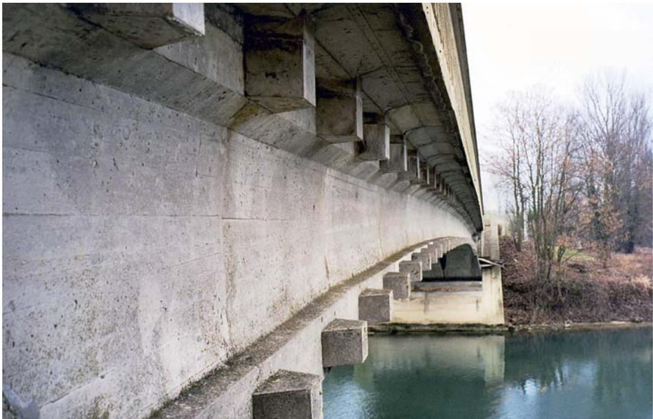
**Figure 2.4.** Détails des ancrages de la précontrainte transversale du pont de Luzancy (SETRA).
