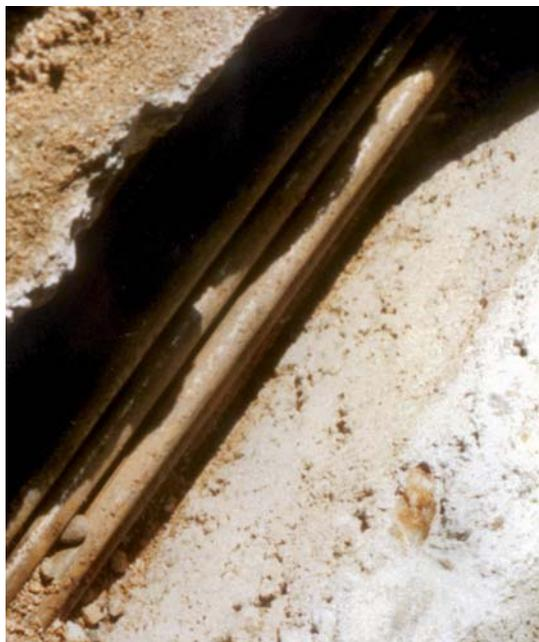
**Figure 2.2.** État des fils du tirant en 1993 (D. Poineau).
