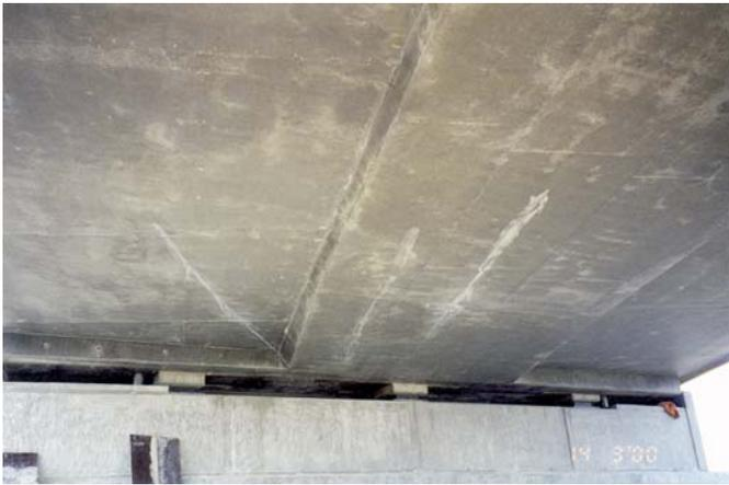
Figure 2.61. Pont à Chasseneuil, fissures de diffusion (D. Poineau).
