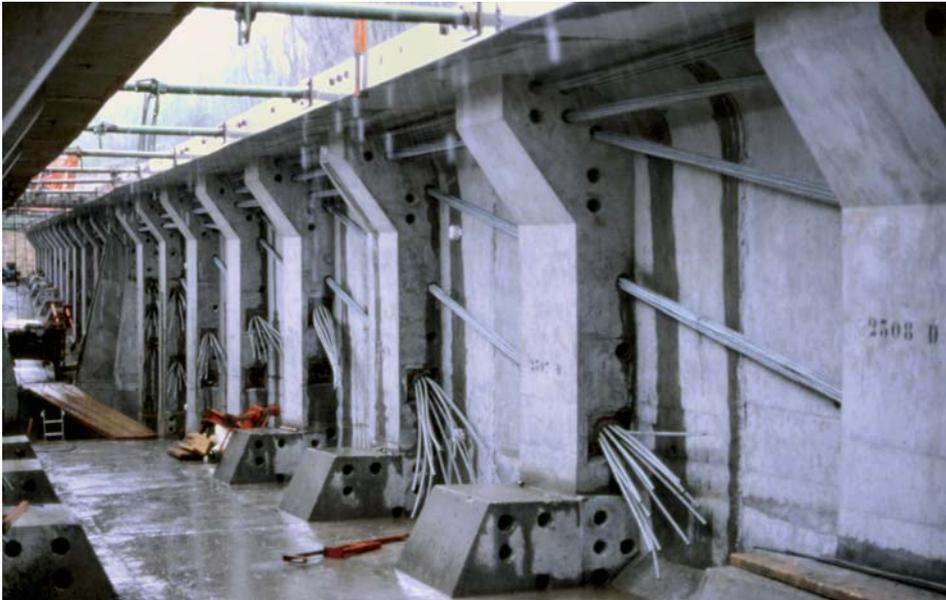
**Figure 2.39.** Viaduc de Sermenaz en cours de construction (D. Poineau).
