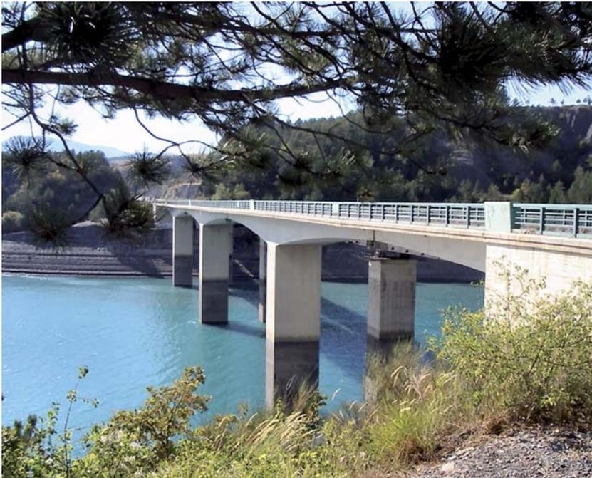
**Figure 2.17.** Pont du Riou-Bourdou (à noter les déformations du tablier vers le bas au milieu des travées) (J.-M. Lacombe).
