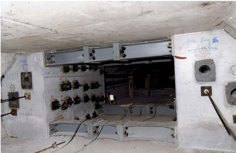
Figure 2.33. Massif d’ancrage de la précontrainte additionnelle de réparation du pont de Châlons-en-Champagne (SETRA).
