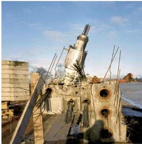
**Figure 2.60.** Pont à Nemours, écrasement total du béton sous l'ancrage et mise à la verticale du vérin (D. Poineau).
