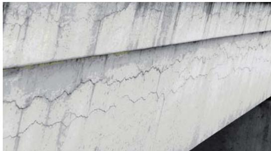
**Figure 2.63.** Poutre de PRAD fissurée par une réaction sulfatique interne (B. Godart).
