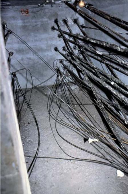
**Figure 2.9.** État des câbles du pont de Can-Bia (D. Poineau).
