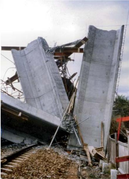
**Figure 2.56.** Accident de Bernay, chutes de poutres de VIPP sur les voies ferrées (D. Poineau).
