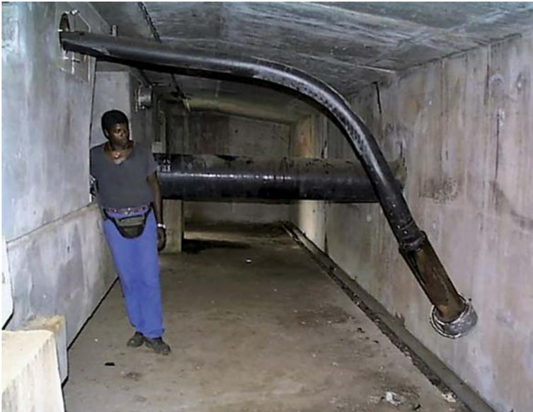
Figure 2.50. Pont de La Rivière-d'Abord, expulsion de l'extrémité du câble rompu (DDE).
