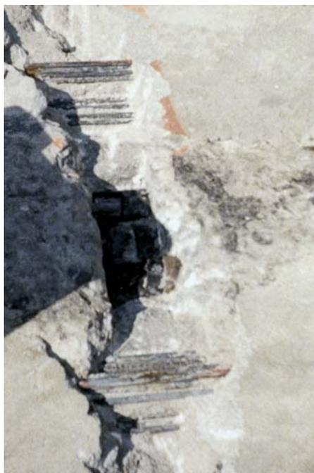
**Figure 2.19.** Conséquences de la mise en place de câbles dans des rainures et de l’absence de gaine au droit d’un joint de réglage bétonné en place (D. Poineau).
