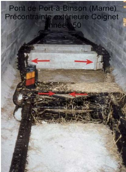
**Figure 2.7.** Câblage Coignet au pont de Port-à-Binson (SETRA).
