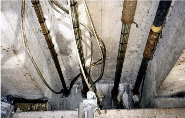
**Figure 2.6.** État de la précontrainte additionnelle galvanisée de 1982 (photo prise en 1998, D. Poineau).
