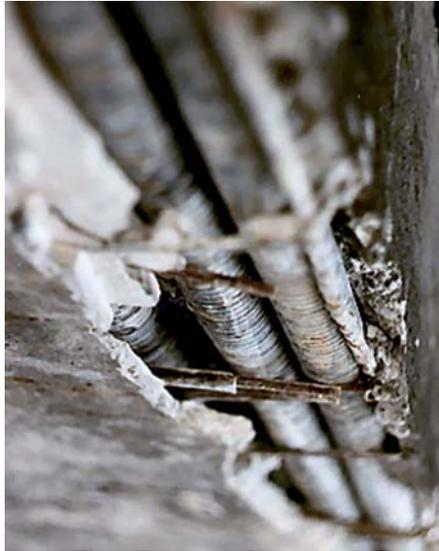
**Figure 2.13.** Exemple de vide masqué par la laitance (LRCP de Strasbourg).
