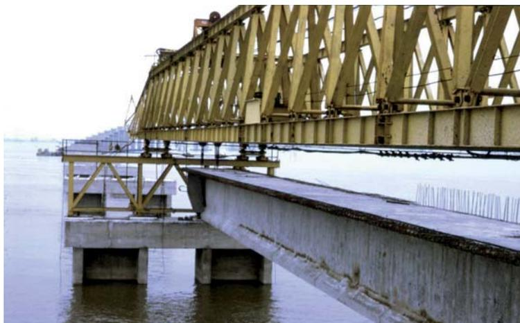
Figure 2.27. Pose des poutres de VIPP au pont de Saint-Nazaire (D. Poineau).
