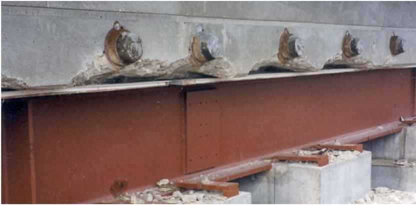
**Figure 2.59.** Pont à Nemours, éclatements du béton des ancrages transversaux (D. Poineau).
