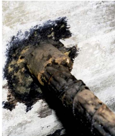
**Figure 2.8.** Ancrage d'un câble, point triple : zone à risque (SETRA).
