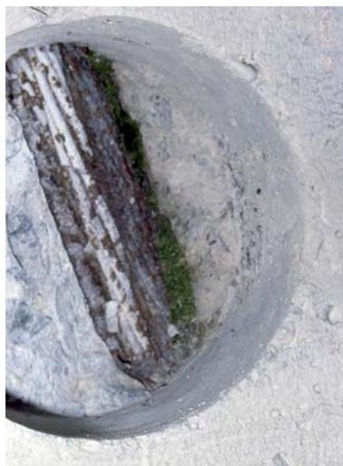
**Figure 2.46.** Fissure d'une poutre du viaduc du Vallon-Charretier, Var (D. Poineau).
