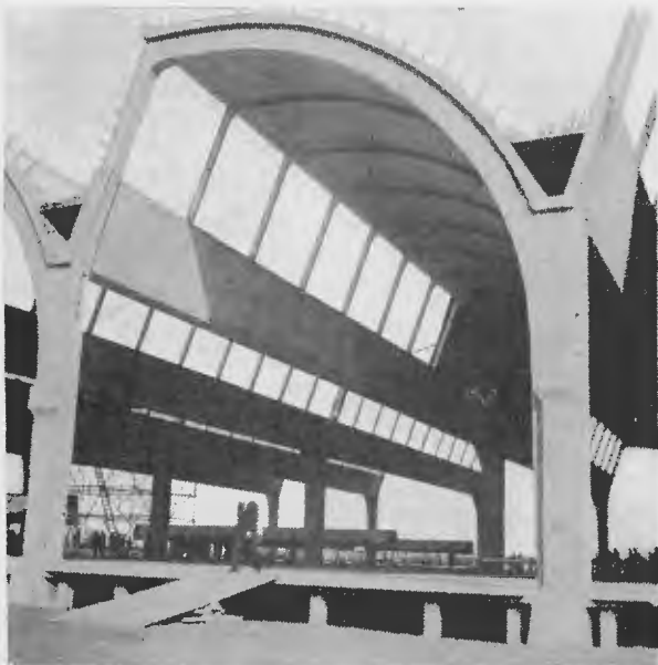
Usine avec toiture en voiles mines précontraints, à Oosterhout (Pays-Bas) (1955).
