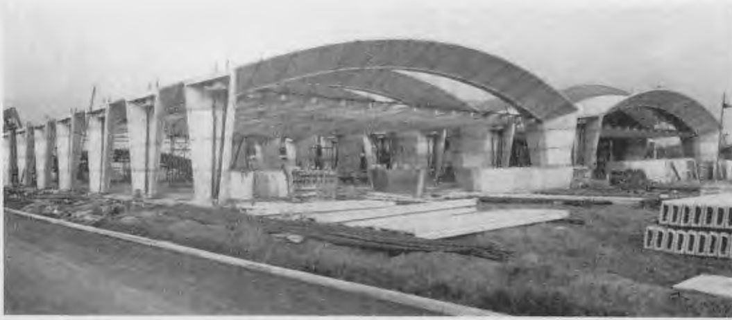
Usine en éléments préfabriqués assemblés par précontrainte, à Denton (Angleterre) (1955).
