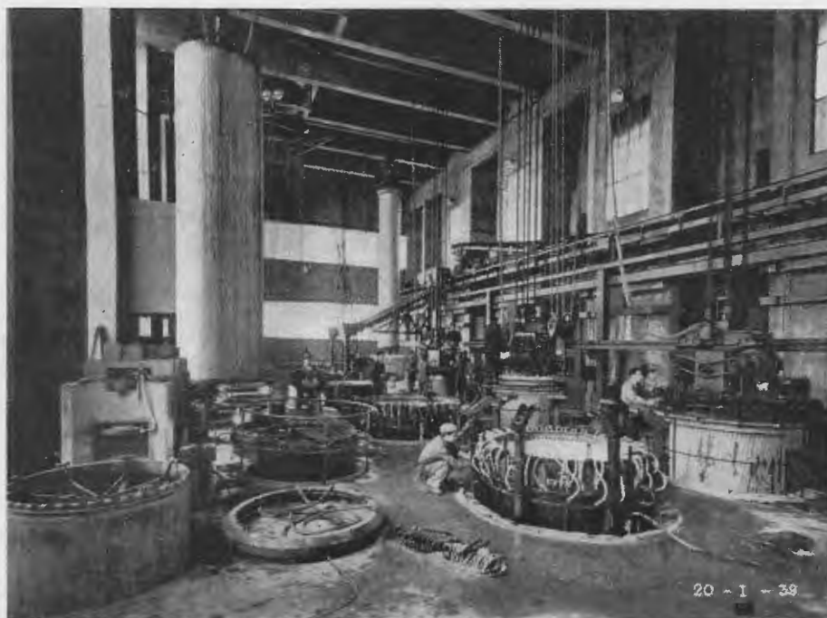
Usine de fabrication de tuyaux de Oued-Fodda (Algérie) (1936-1940).
