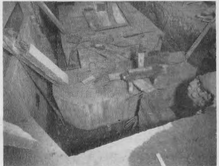
Relevage de l'ancienne gare maritime du Havre. Création d'une précontrainte de 1 000 t dans un ensemble d'anciennes fondations (1934).
