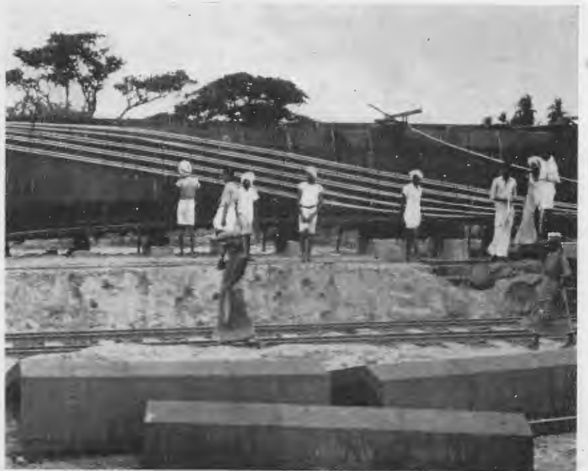
Pont sur le Coleroon (Inde) (1956). Câblage d'une poutre.
