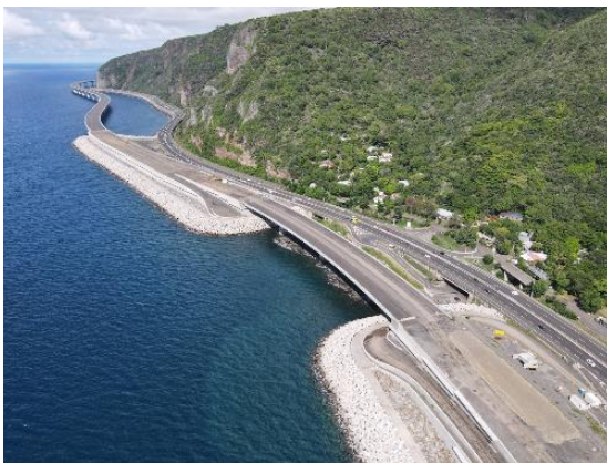
Echangeur de la Grande Chaloupe - NRL Crédit photo : T. Vessiot VCT NRL
