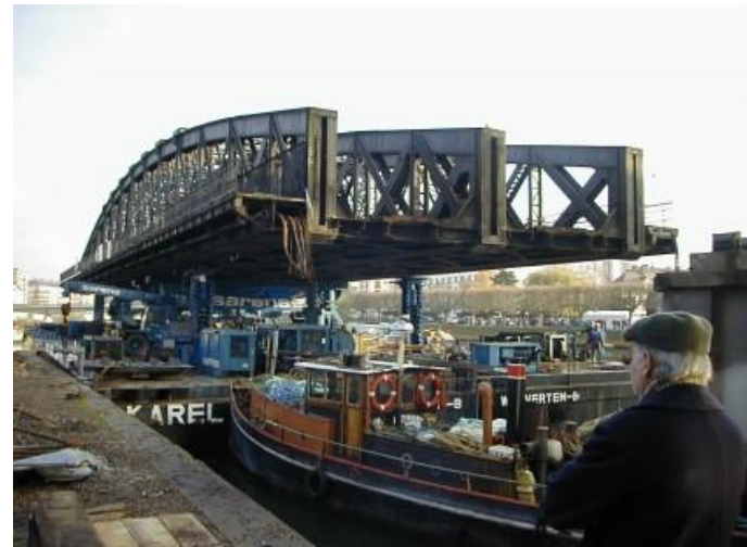
Démontage du pont ferroviaire de Pontoise (1861 – 1999)
