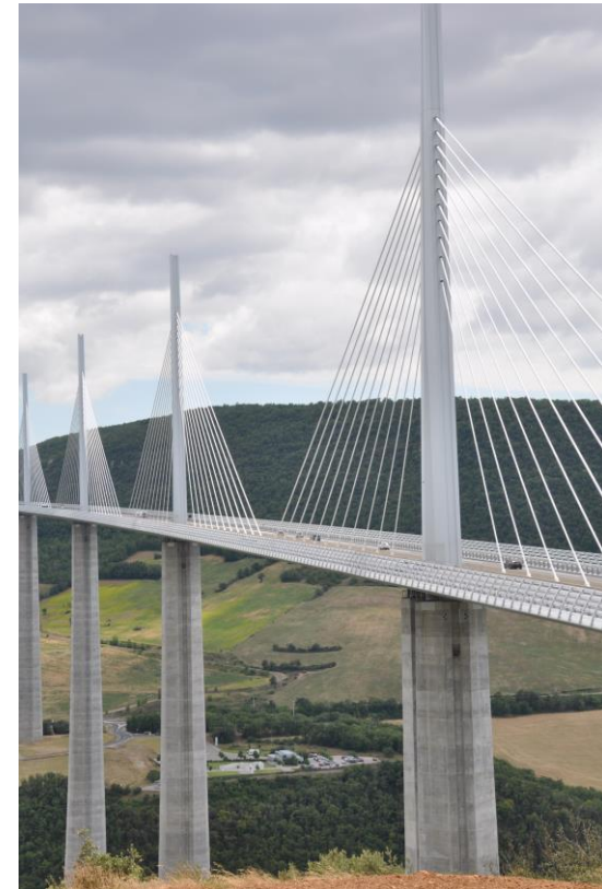
Viaduc de Millau
