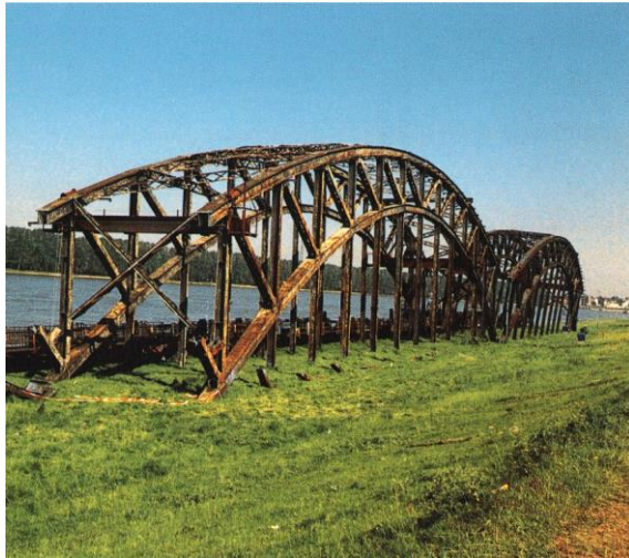
Démontage du pont de Hammer à Düsseldorf
