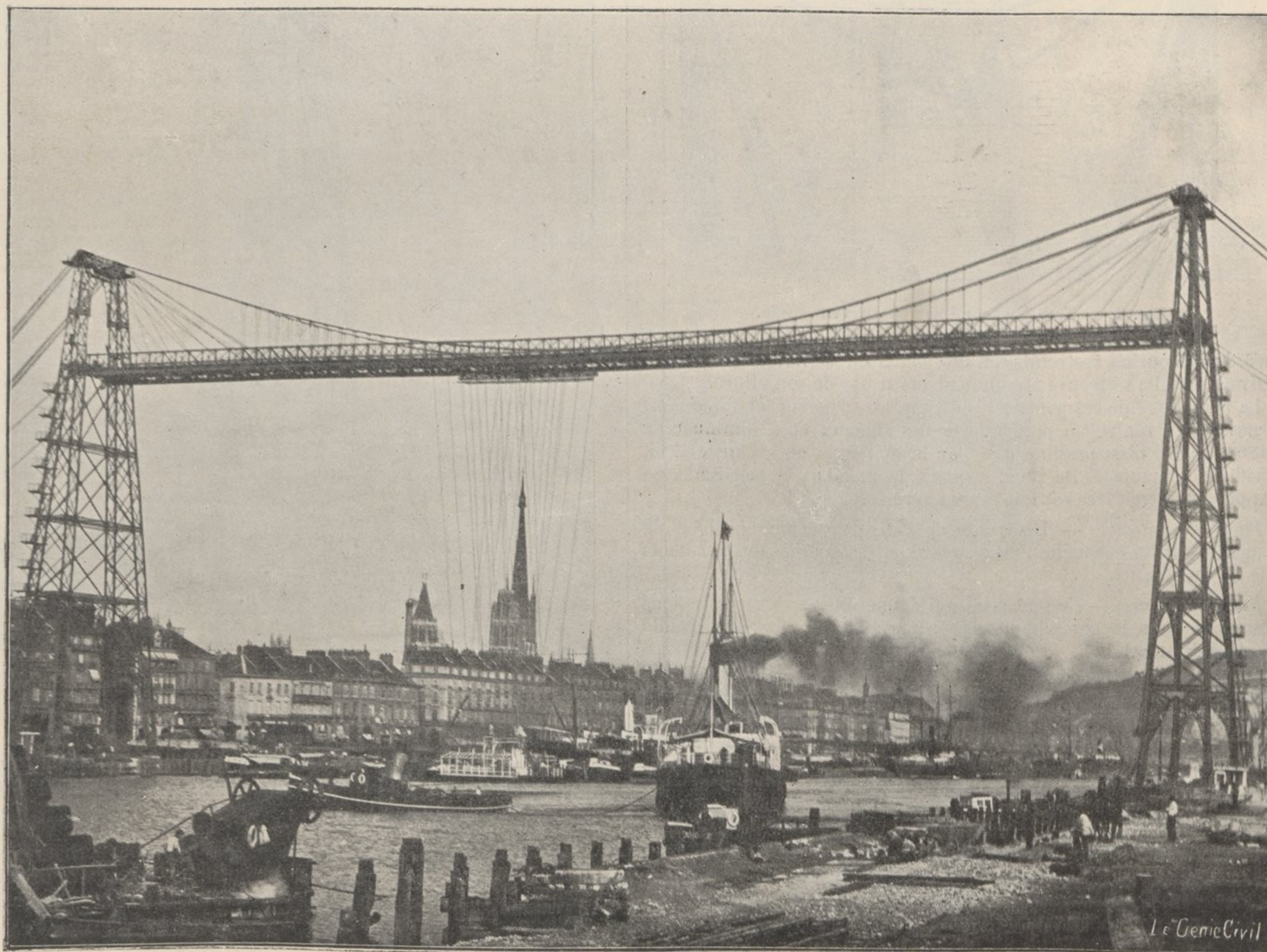
FIG. 1. — PONT A TRANSBORDEUR DE ROUEN.
