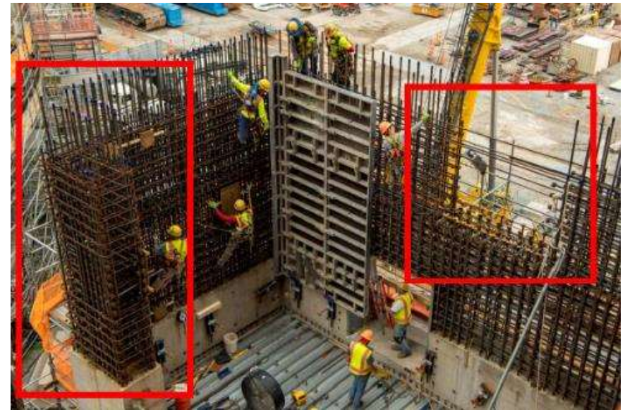
Utilisation des T-headed bars sur Vogtle
