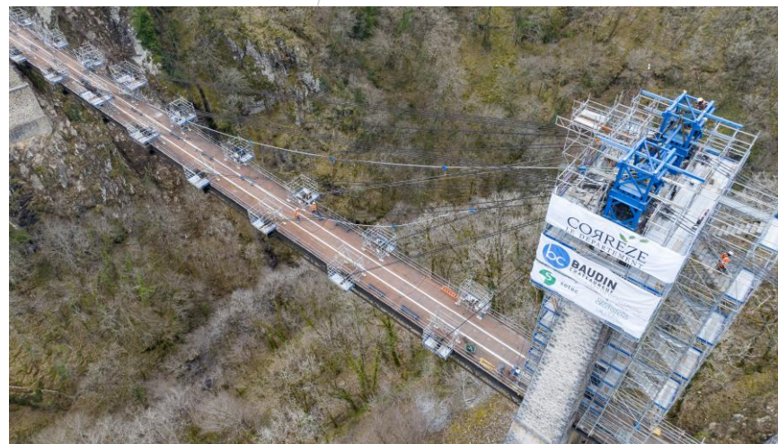
Viaduc des Rochers Noirs, en Corrèze
