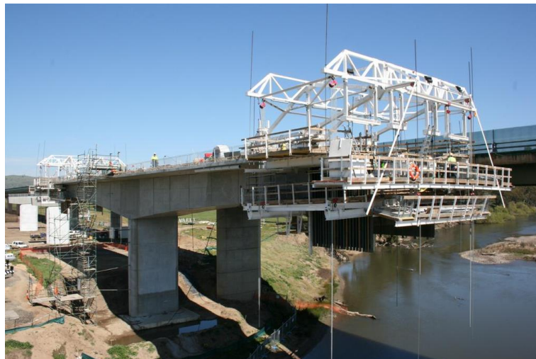
Pont de Sheahan , en Nouvelle Galles du Sud pont en encorbellement, travée principale de 87m
