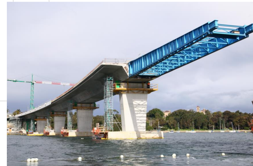
Construction du Pont Iron Cove à Sydney Pont poussé multi-travées, 475m, travée 53m
