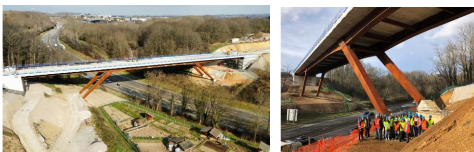
Visite technique franchissement A20 à Limoges (9 Mars 2023)
