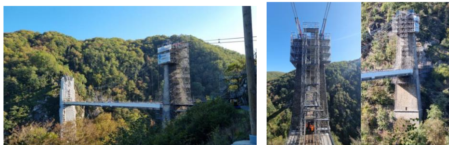
Visite technique Rénovation du viaduc des rochers noirs (10 Octobre 2023)
