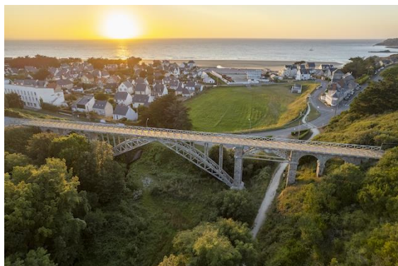
Viaduc de Caroual
