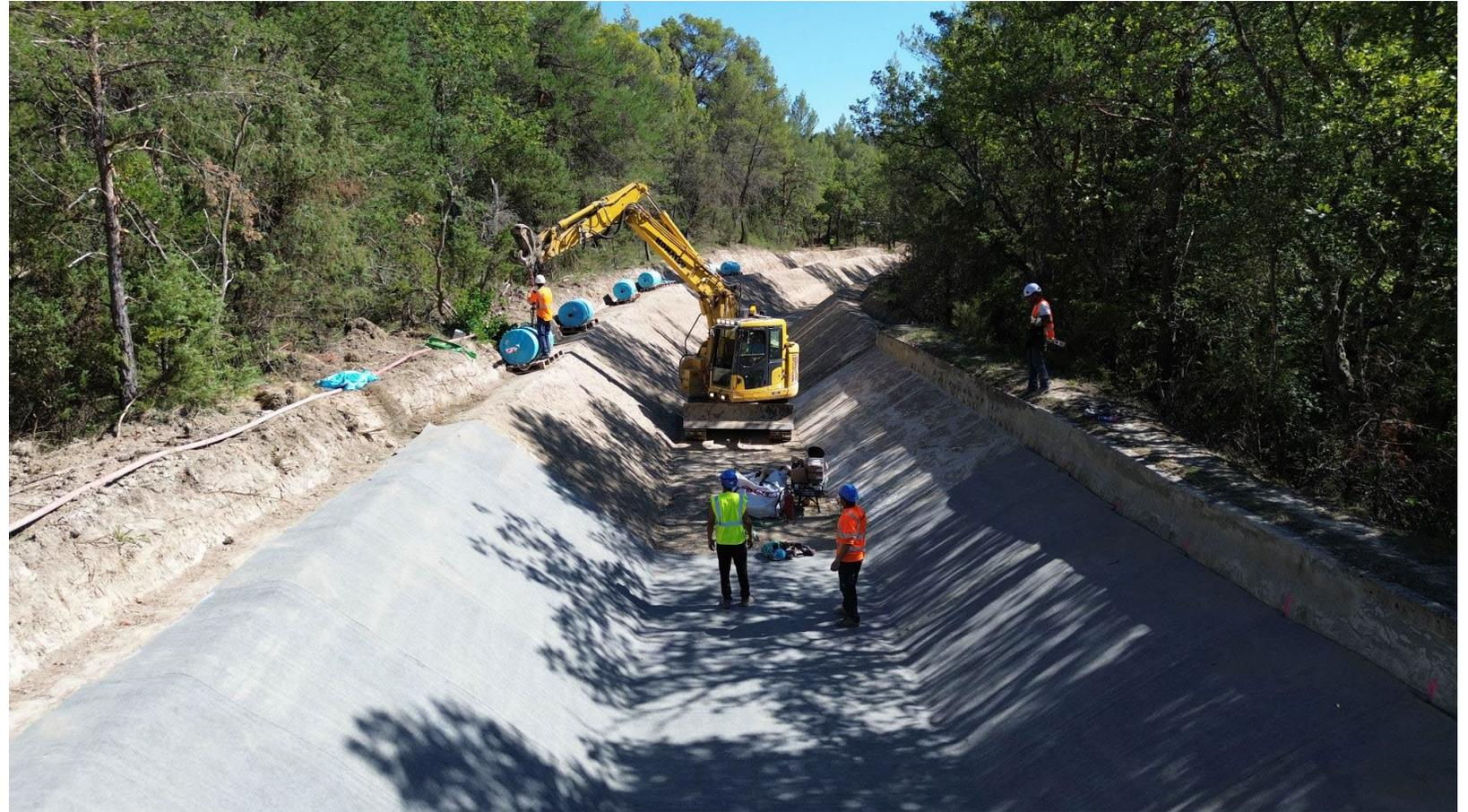
Les chevauchements ont été nettoyés en brossant l'excès de poussière de la surface du géotextile et en essuyant le support de la géomembrane. Un cordon d'adhésif de 8 mm a été extrudé à chaque chevauchement pour fournir un joint à faible perméabilité.
