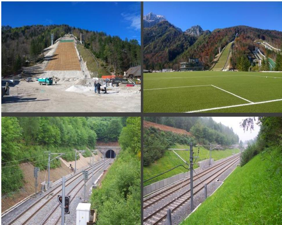
▲ Stabilisation et soutènement des terres à l'aide d'ancrages et d'un parement flexible végétalisé
