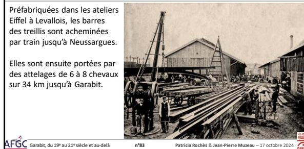
Préfabriquées dans les ateliers Eiffel à Levallois, les barres des treillis sont acheminées par train jusqu'à Neussargues.
