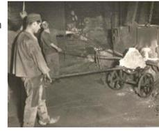
**Principal inconvénient : ce matériau ne peut être fondu.** On obtient ainsi une sorte de pâte qui ne peut être mise en forme que par laminage ou forgeage (d'où l'autre nom de « **fer forgé** »).
