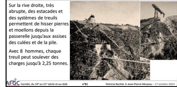
Sur la rive droite, très abrupte, des estacades et des systèmes de treuils permettent de hisser pierres et moellons depuis la passerelle jusqu'aux assises des culées et de la pile.
