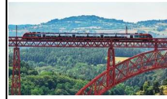
A Garabit, la voie est en partie intermédiaire des poutres principales, à 1,66 m au-dessous des semelles supérieures. Les trains sont mieux protégés du vent et mieux contenus en cas de déraillement.
