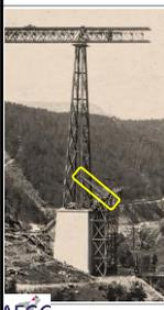
Des câbles de haubanage sont alors attachés à l'extrémité de chaque membrure inférieure pour maintenir à la position requise les éléments suivants, l'augmentation de la masse devenant incompatible avec la capacité des échafaudages.
