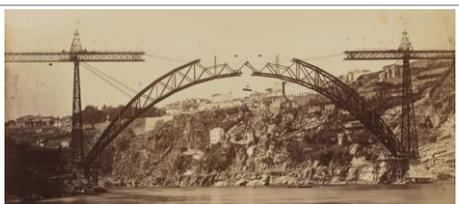
Le montage de Garabit s'inspirant de celui du Maria Pia. Les piles principales et le tablier vont donc être utilisés pour monter les 2 demi-arcs en porte-à-faux.
