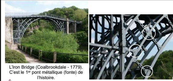
L'iron Bridge (Coalbrookdale - 1779). C'est le 1<sup>er</sup> pont métallique (fonte) de l'histoire.
