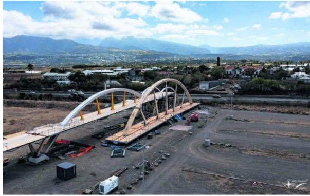
Livré en morceaux, la passerelle a été assemblée et soudée sur le site de Pierrefonds. (Photo DR)
