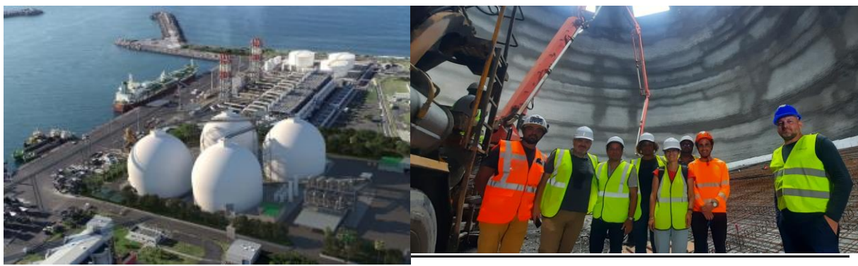
Vue aérienne des dômes de stockage ALBIOMA Le Port
