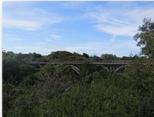
Viaduc de Port-Nieux, Harel de la Noë (Côtes d'armor)
