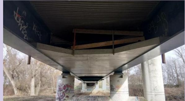
*Renforcement d'un bipoutre mixte par mise en œuvre d'une double action mixte dans les sections proches des piles*
