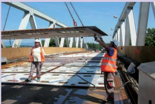
*Dalle préfabriquée en BFUP en cours de mise en œuvre*
