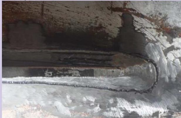
*Martelage d'un pied de cordon de soudure*
