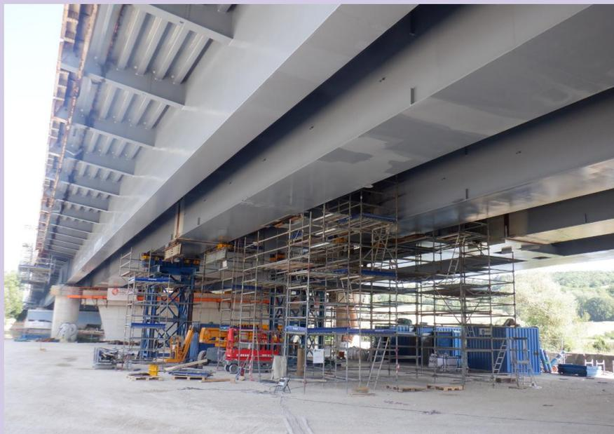
*Ajout de caissons en acier en sous œuvre du viaduc d'Autreville dans le but de le renforcer*
