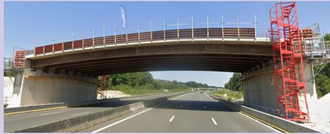
*A Gauche : Ouvrages de l'A43 sur la Leysse - Détail de l'extrémité intégrale du tablier
