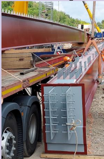
Livraison des poutres sur site et mise en place à la grue – Pont de Rosières-aux-Salines
