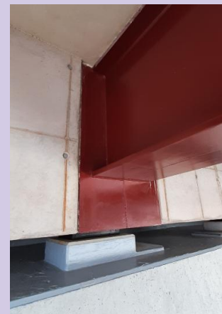
Détails des zones de liaison des poutres métalliques dans les entretoises en béton armé
