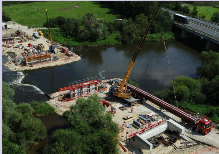
Livraison des poutres sur site et mise en place à la grue – Pont de Rosières-aux-Salines
