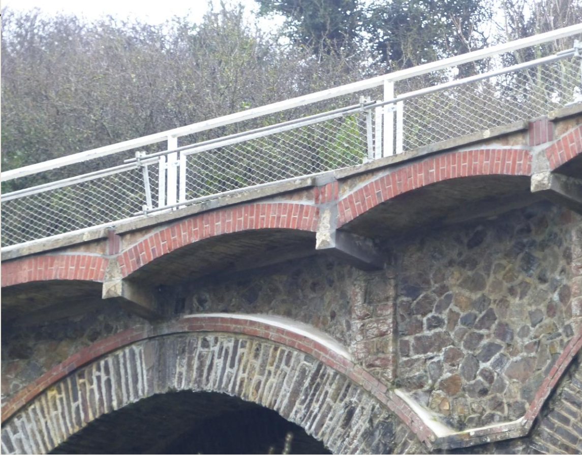
1 er mars 2022, avant travaux
