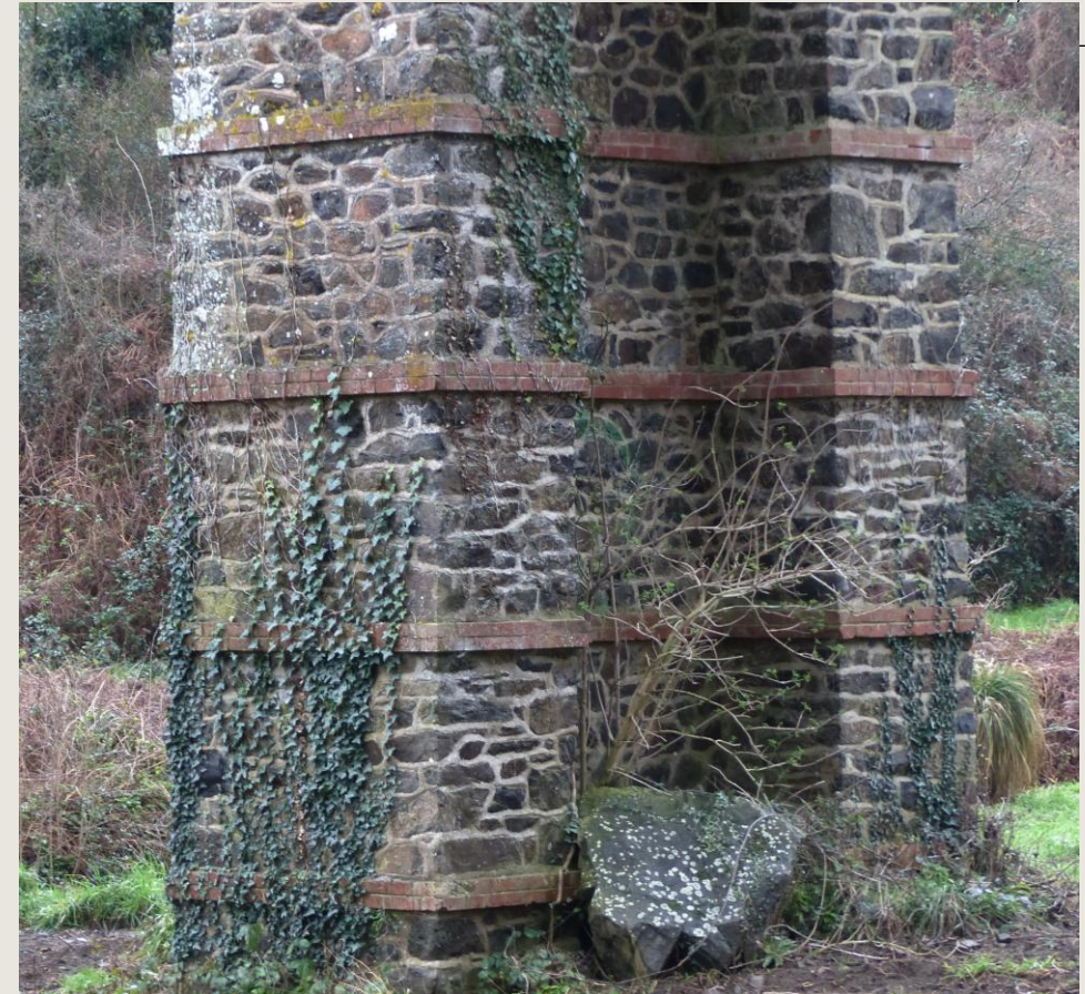
Viaduc de Douvenant, 1 er mars 2022, avant travaux
