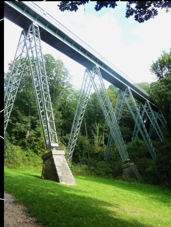
La passerelle de l'ancienne voie ferrée Brest-Lambézellec - © Henri Moreau
