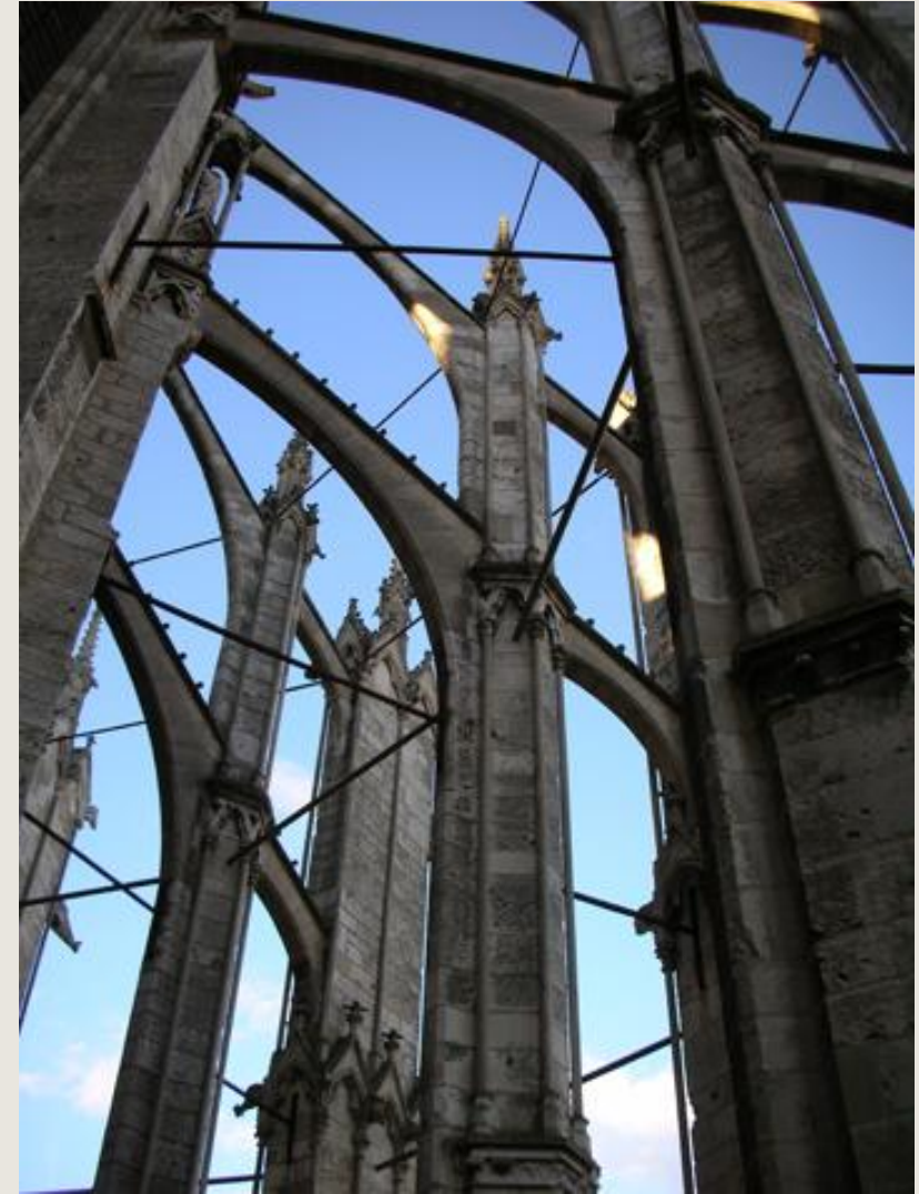
Tirants en acier entre les arc-boutants de la cathédrale Beauvais
