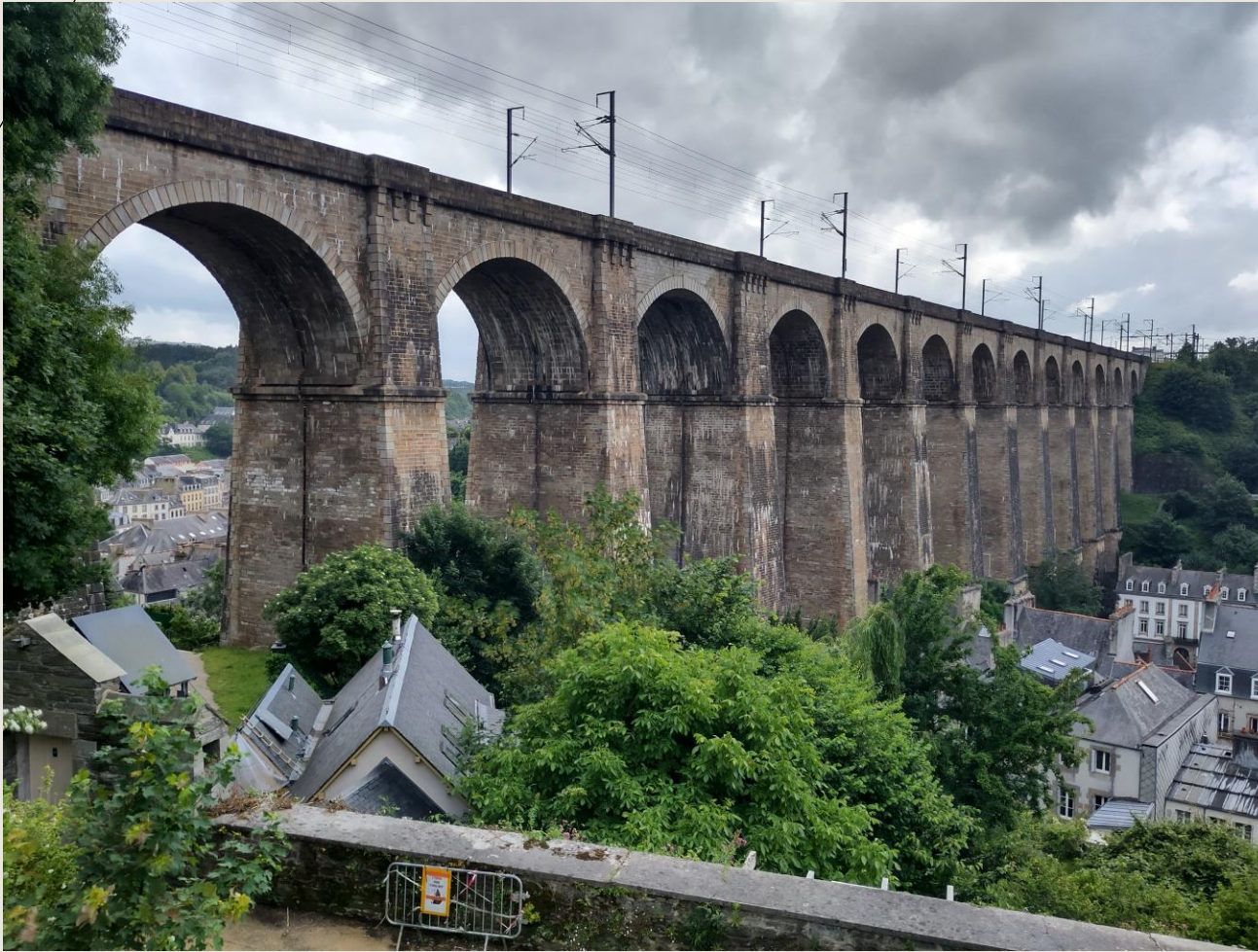
Viaduc de Morlaix, 2025
