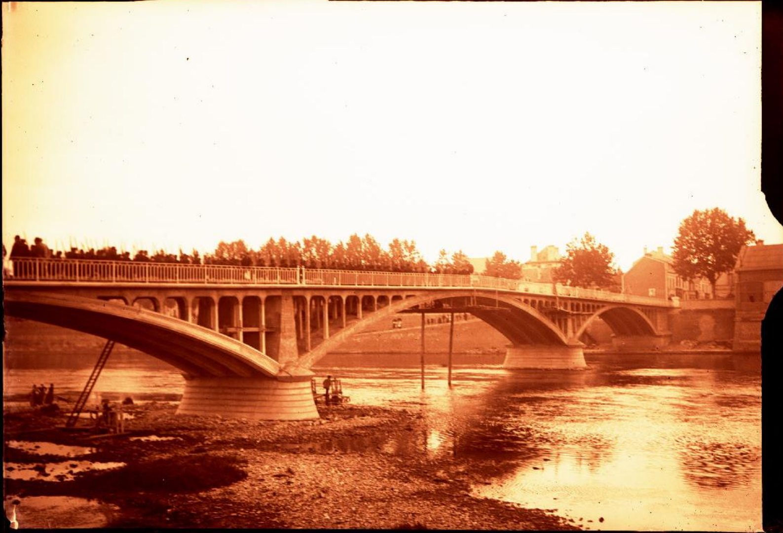
Pont de la Manufacture (Châtellerault) lors des essais, 1900
