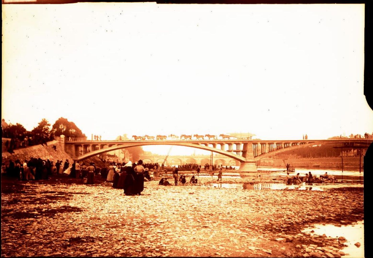
Pont de la Manufacture (Châtellerault) lors des essais, 1900
