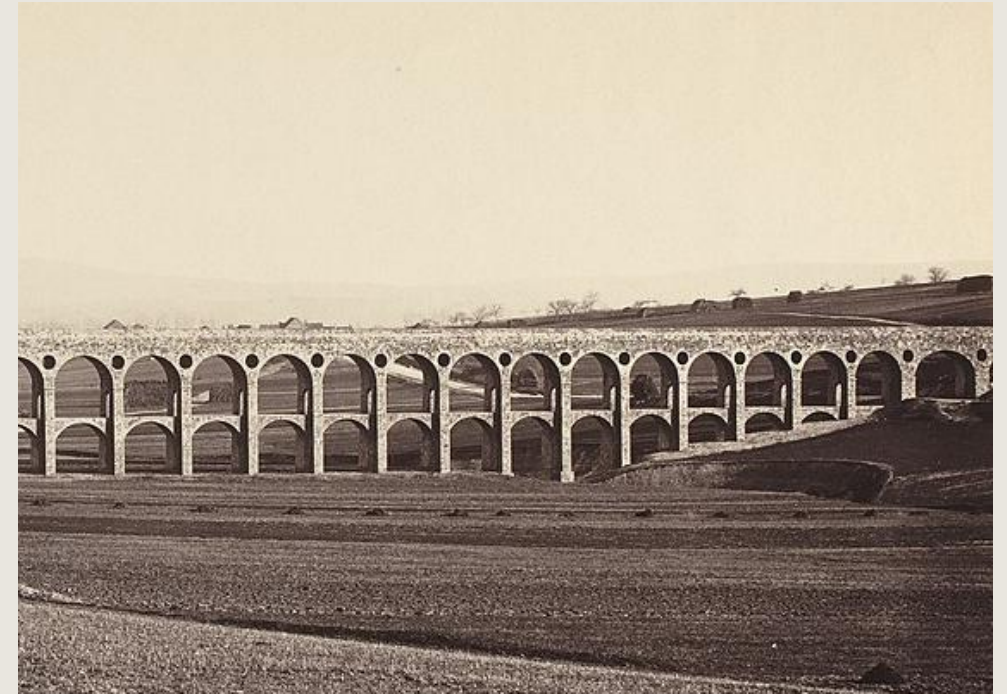
Arcades de l'aqueduc de la Vanne à Cuy, par le photographe Auguste Hippolyte Collard, en 1873
