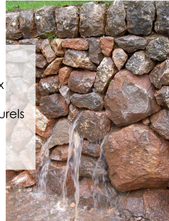
© P. Alvaro Frotté – Mur en pierre sèche soumis à un écoulement
