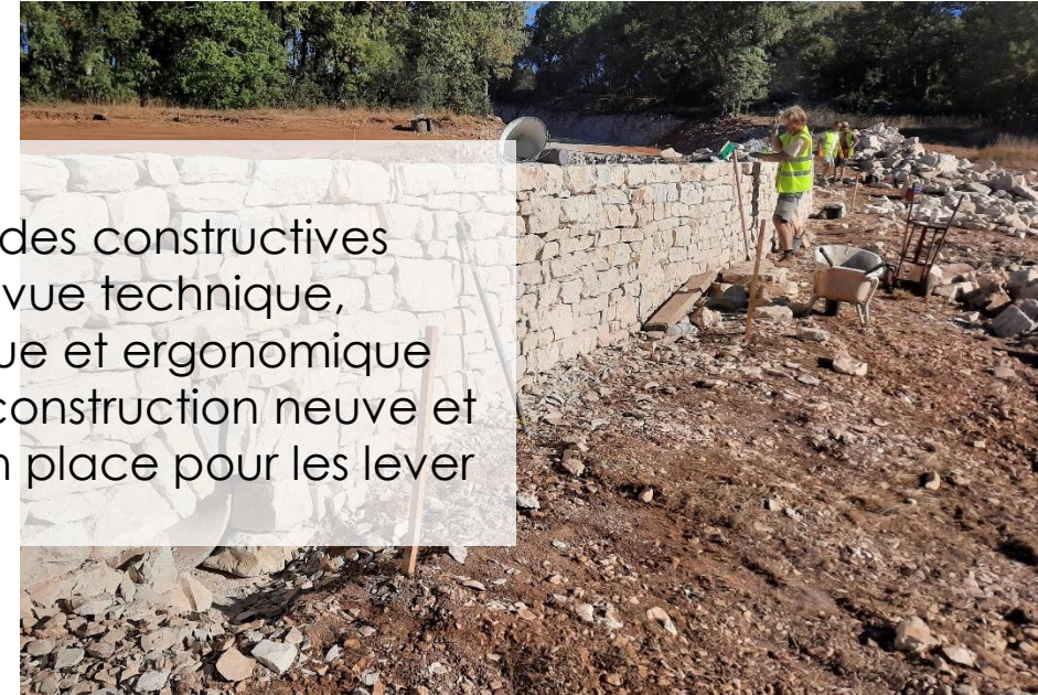
© G. Viossanges – Construction d'un mur de soutènement en pierre sèche à Rocamadour (46)
