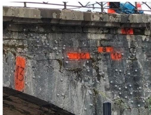
Corrélation d'images : Prise de vue et traitement d'images par caméra. Analyse des champs de déplacement des « pixels » de l'image.
