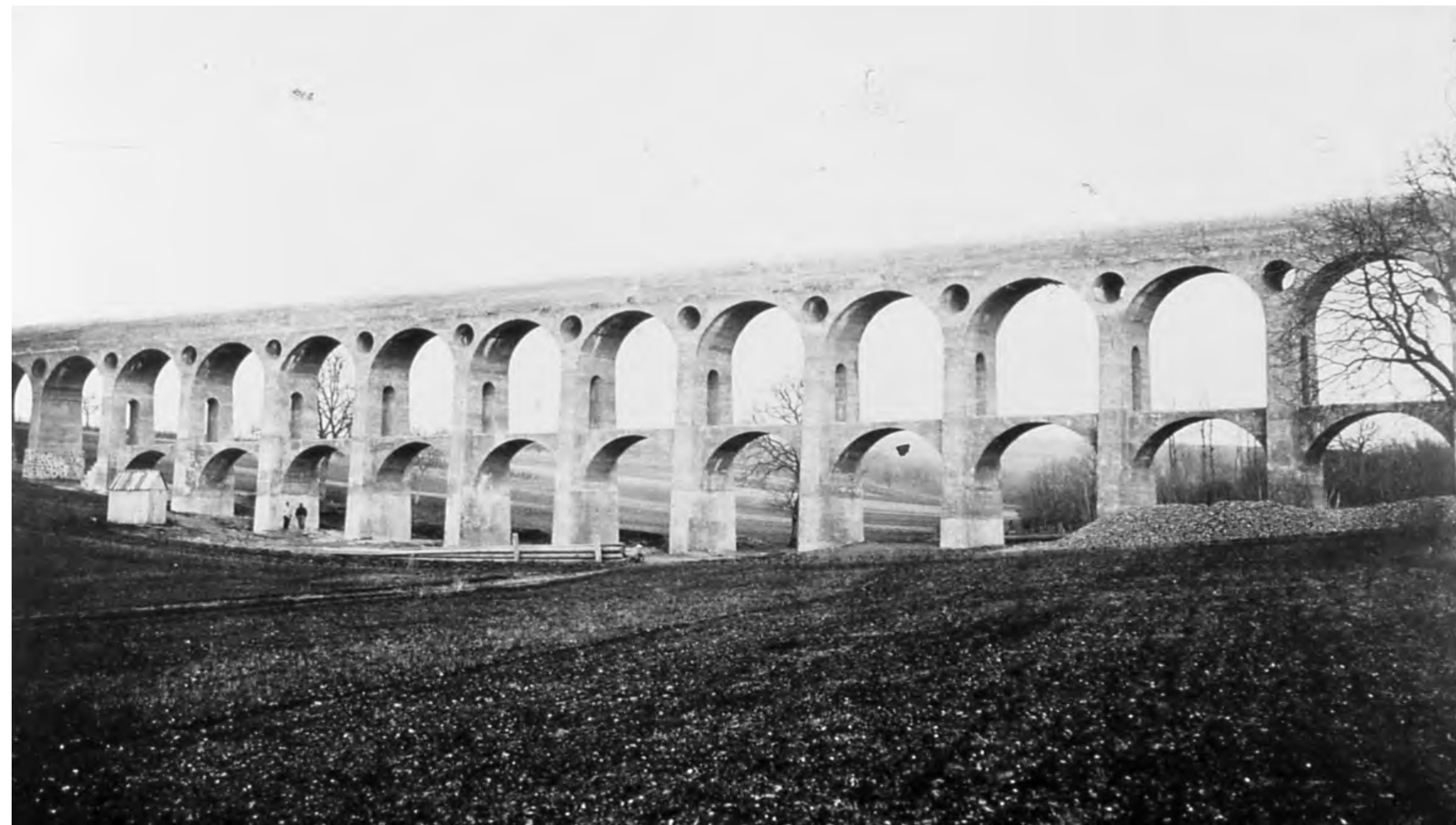
Un des ouvrages de l'aqueduc de la Vanne en béton aggloméré, Edmond Coignet, 1867-1874
