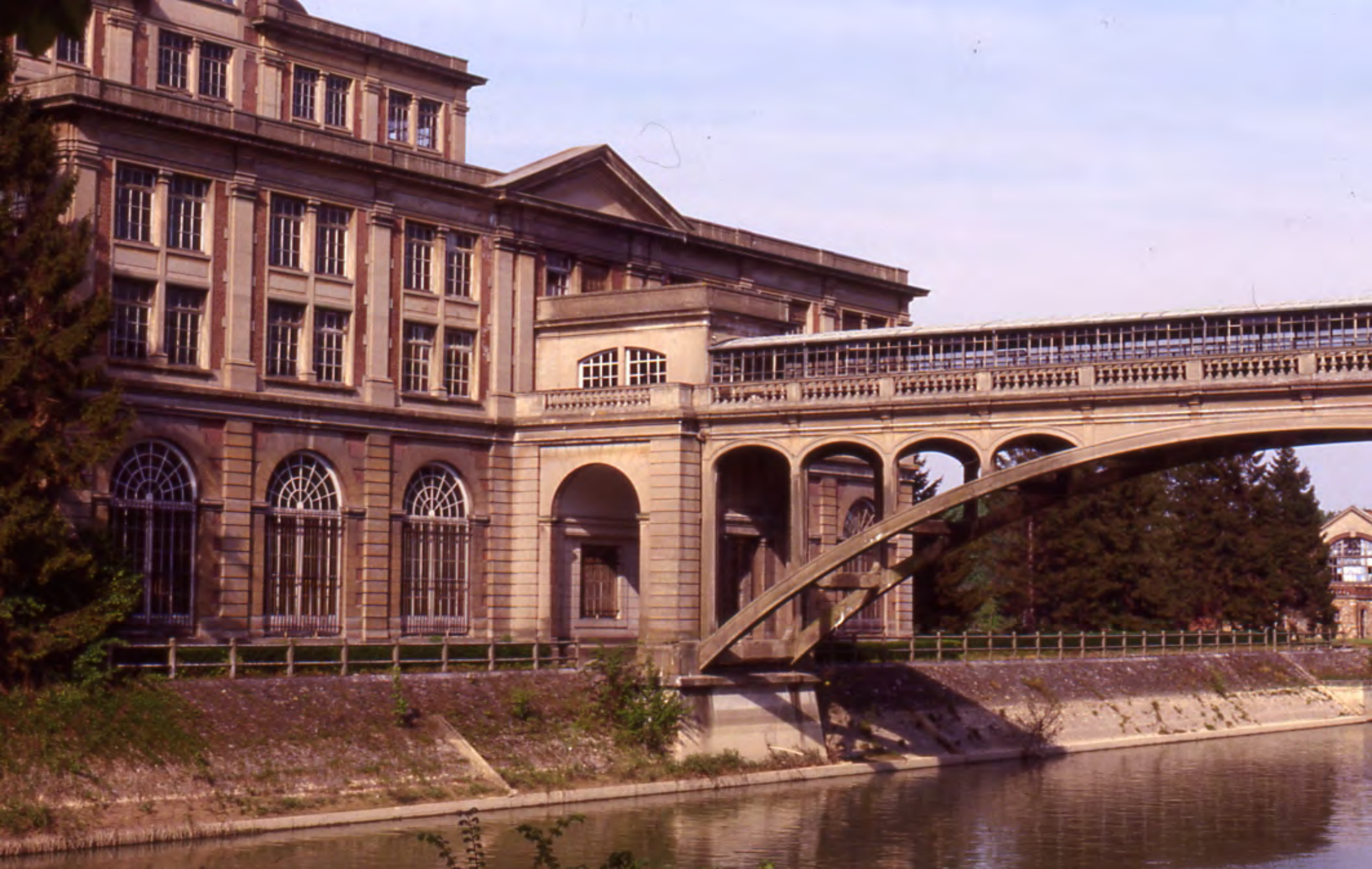
Pont à l'usine Menier à Noisiel par Coignet, , 1905 Bertrand Lemoine - 2023
