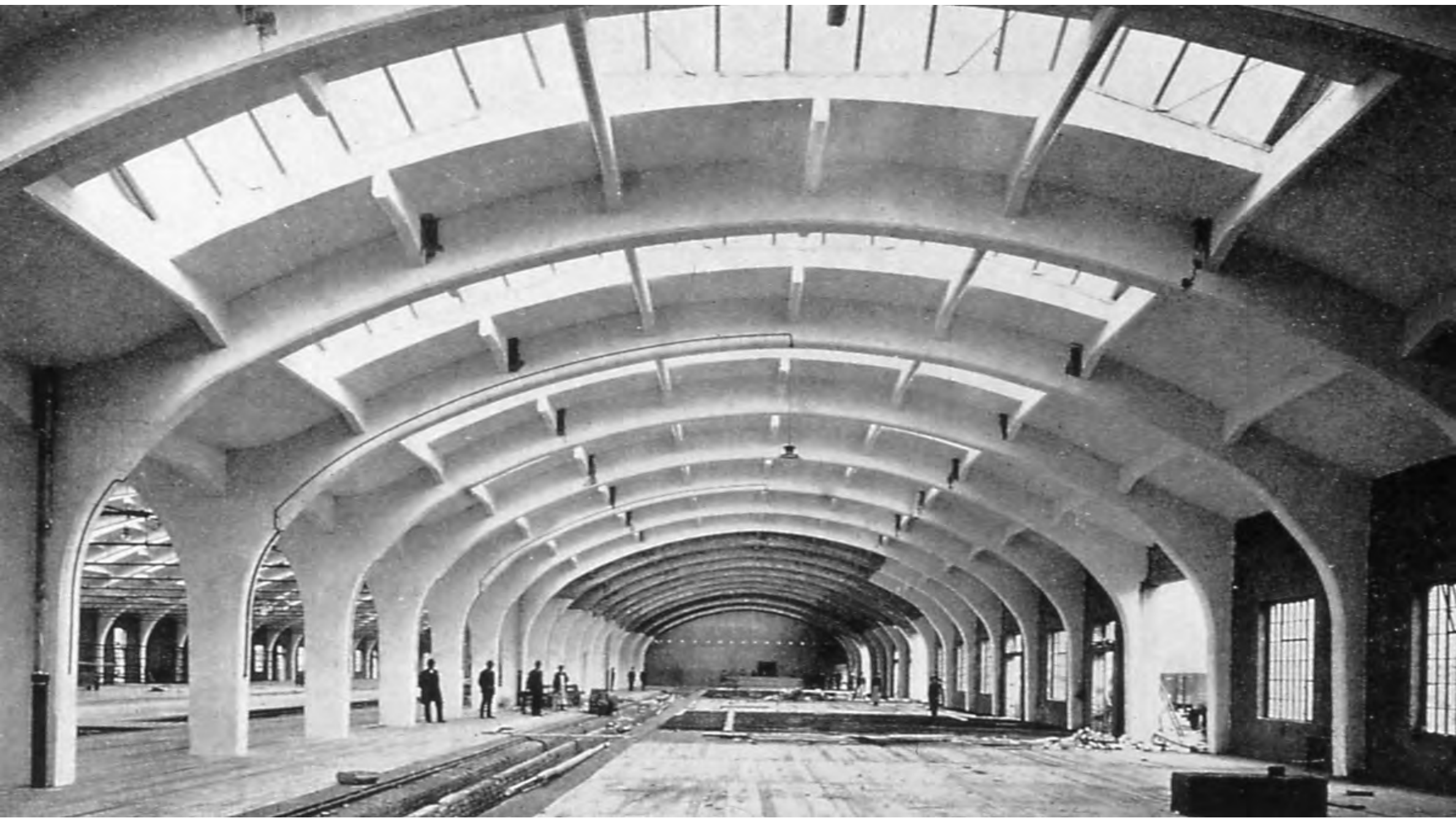
Usine de produits émaillés à Ligetfalu, Heinrich Zieger architecte, Ways & Freytag constructeurs, 1912.
