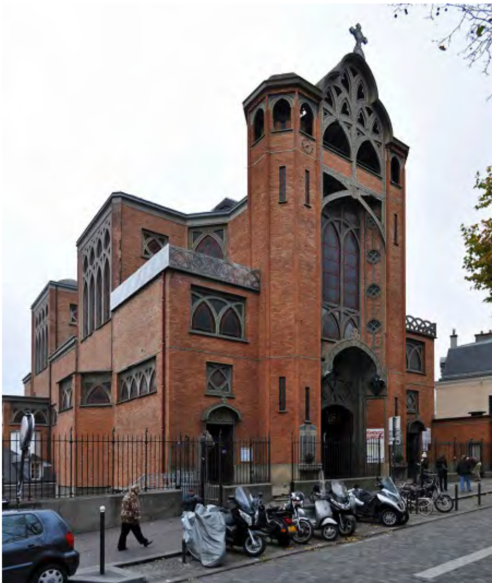
L' église Saint-Jean de Montmartre, Anatole de Baudot architecte, Paul Cottancin constructeur, 1899-1903.
