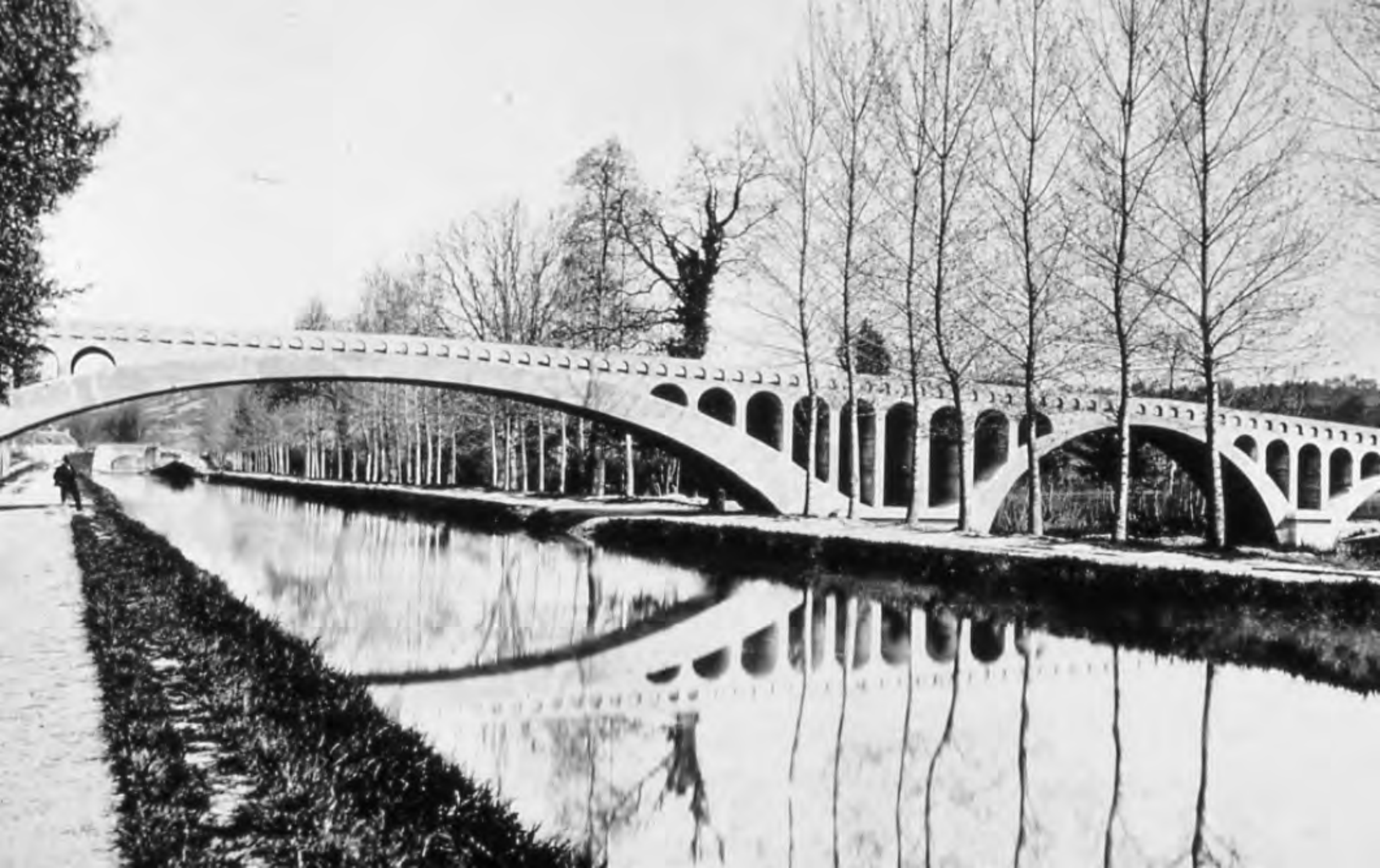
Un des ouvrages de l'aqueduc de la Vanne en béton aggloméré, Edmond Coignet, 1867-1874.
