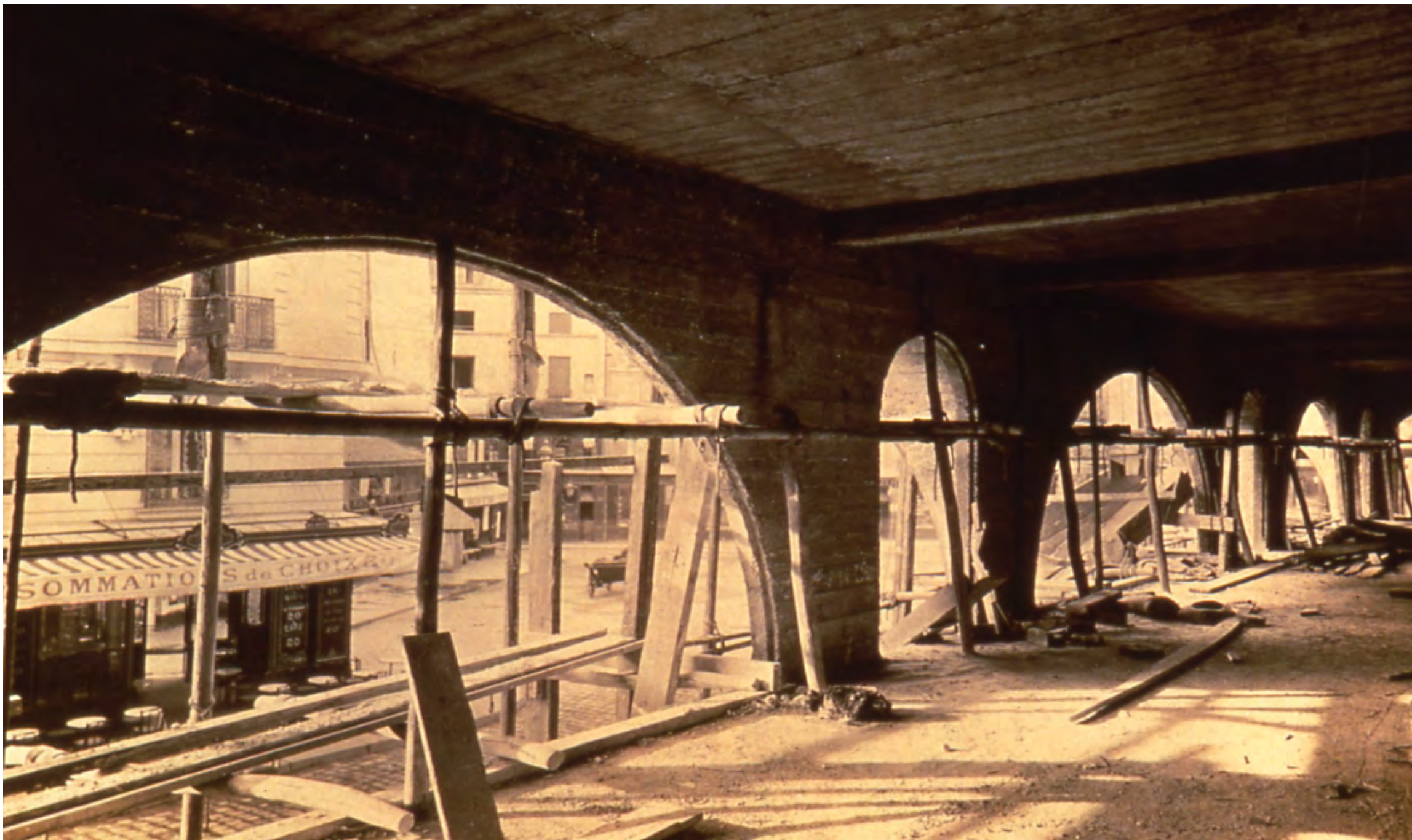
Chantier de l'immeuble Hennebique, rue Danton, 1899. Bertrand Lemoine - 2023
