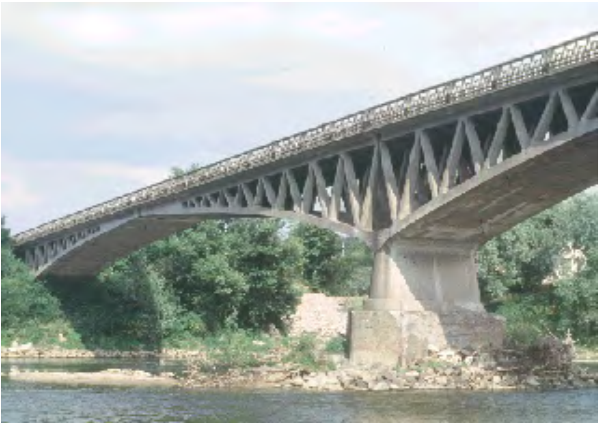
Pont du Boutiron, Freyssinet, 1911
