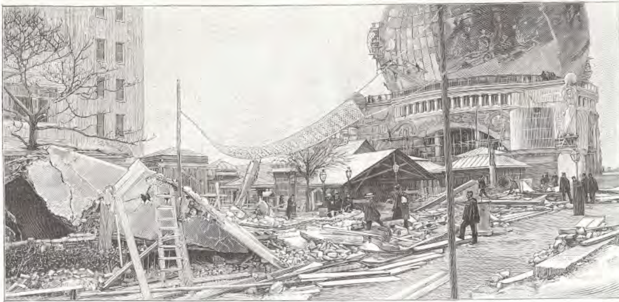
La passerelle de l'avenue de Suffren, après son écroulement.
