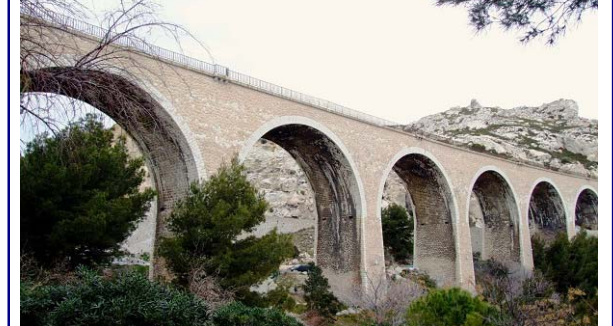
Viaduc de Corbières
