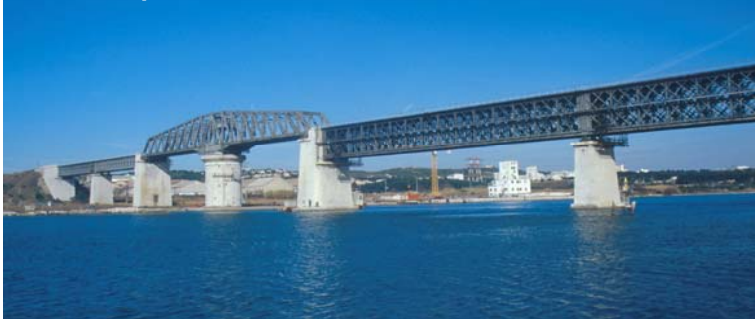
Viaduc et pont tournant de Caronte
