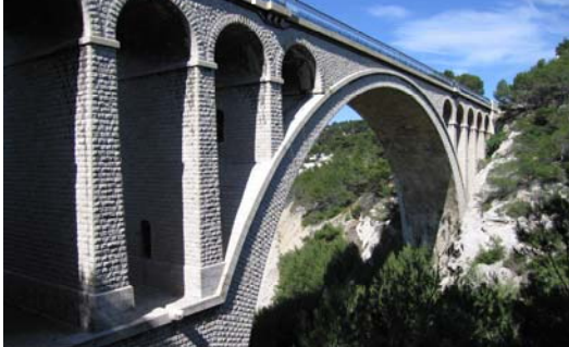
Pont de la Calanque des eaux salées
