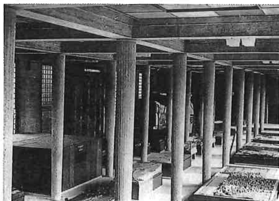
Le Musée des Travaux Publics avant-guerre. (Construction Moderne).
