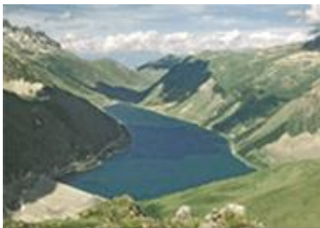
Barrage de Grand'Maison Un réservoir de 173 millions de m 3 .
