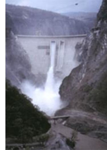
Monteynard (Isère) évacuateur en saut de ski (DR Coyne & Bellier)
